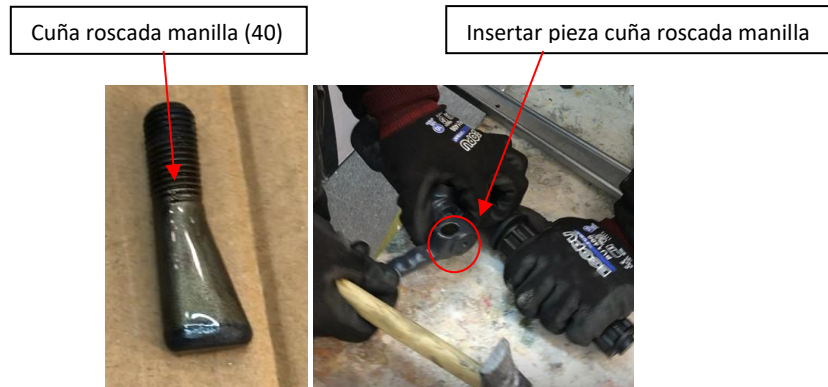
Figura 148: 22 despiece: cuña roscada manilla y arandela grover M10
