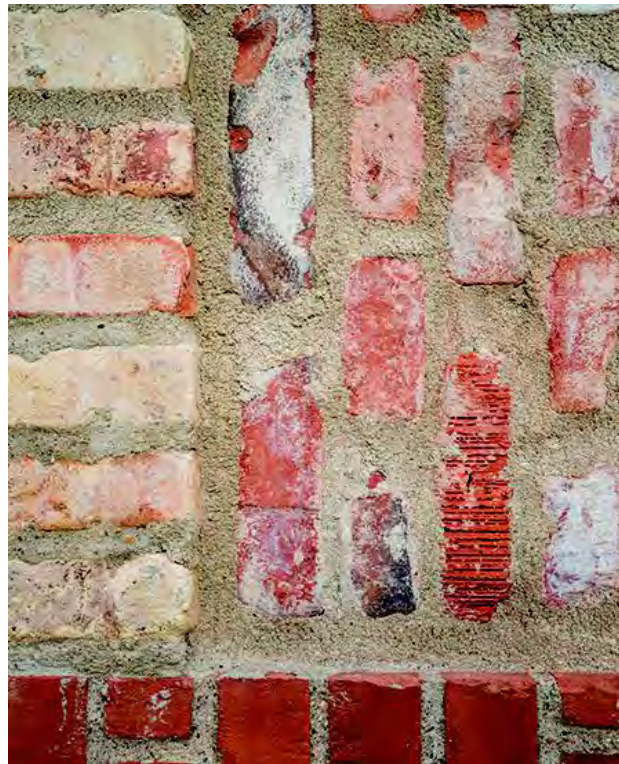
Ilustración 2. Detalle de la pared con ladrillos verticales y horizontales.
