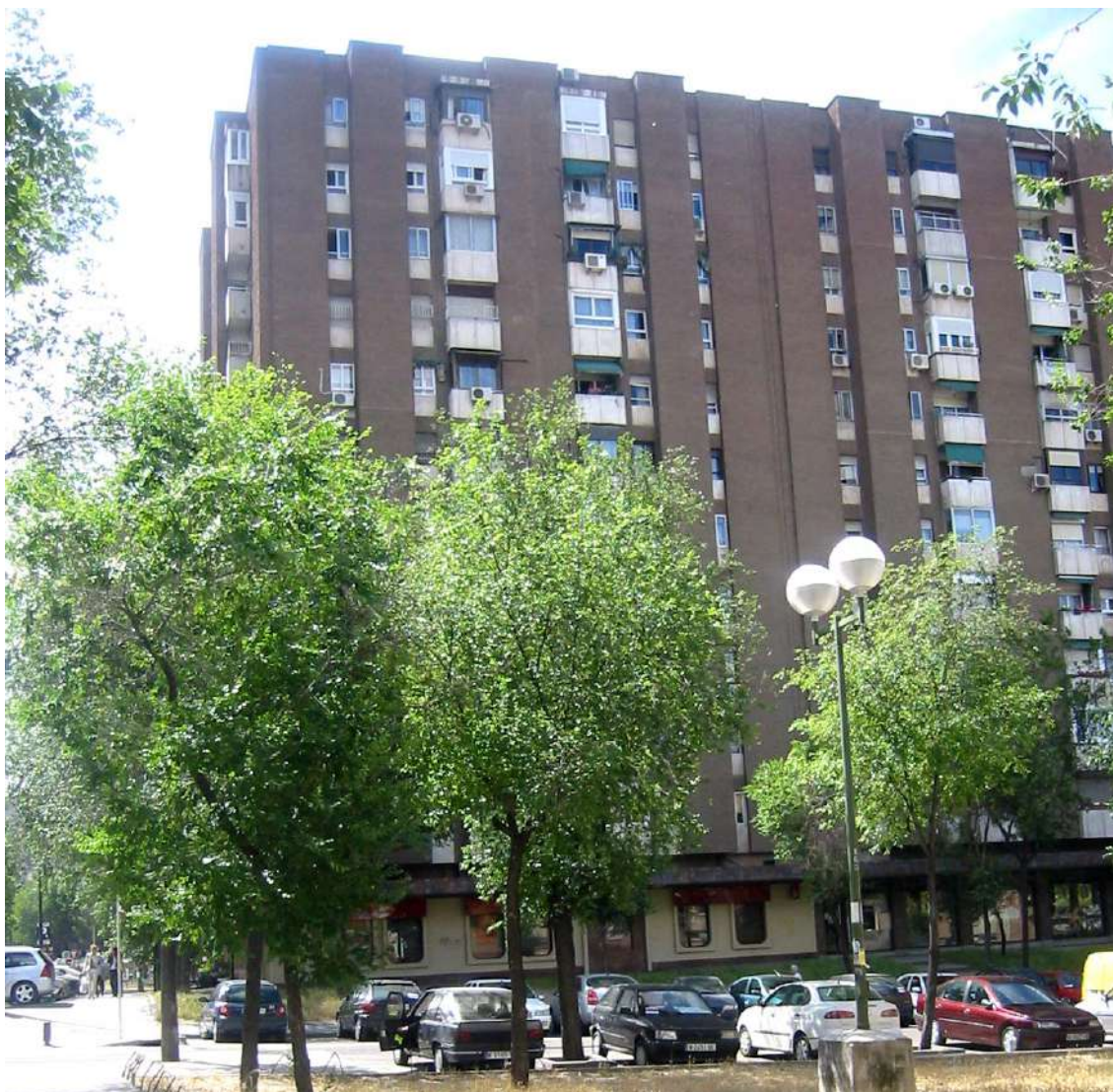
Figura 20. Torres en H (12 plantas) en el polígono C, con cerramientos indiscriminados de terrazas y colocación de antenas, toldos, aparatos de aire acondicionado, etc.
