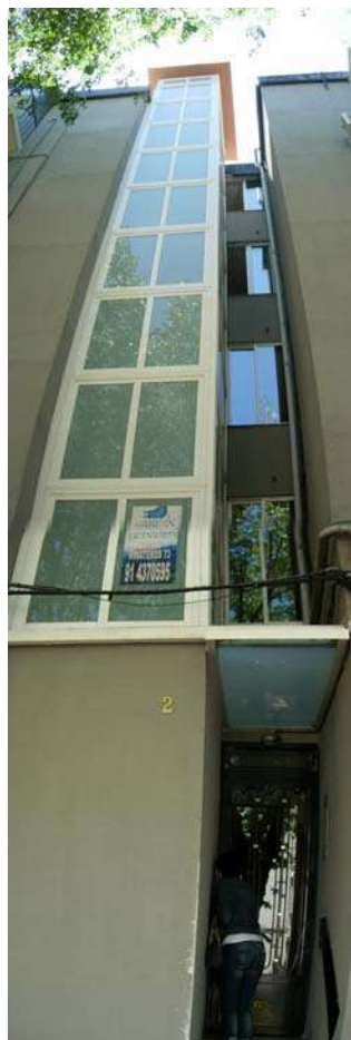
Figura 21. Inclusión de ascensor en interior de bloque tipo T, con problemas de accesibilidad universal (polígono A)
