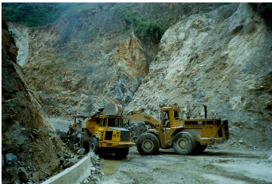
Figura 65. Excavaciones en trabajos de construcción de carretera en rocas del Complejo Quebradagrande, vía Medellín – Santa Fe de Antioquia. Fotografía: el autor
