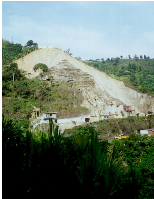
Figura 52. Cantera de arena en rocas del Stock de Amagá con alta meteorización. Fotografía: el autor.
