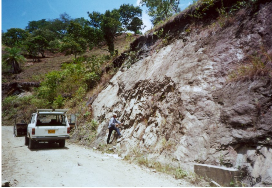
Figura 80. Corte en la carretera con afloramiento de rocas de las Anfibolitas de Sucre.
