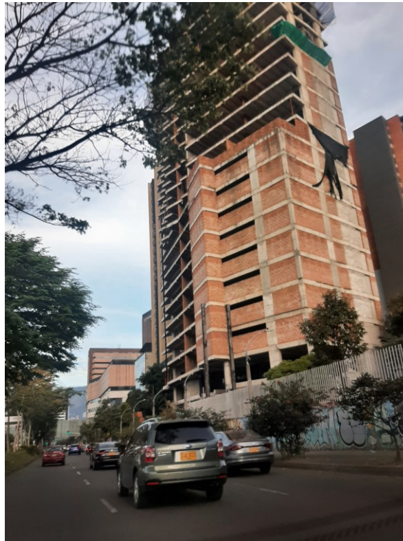
Figura 91. Construcción de edificios para vivienda urbana y oficinas en el sector sur del Área Metropolitana, Medellín. Fotografía: el autor
