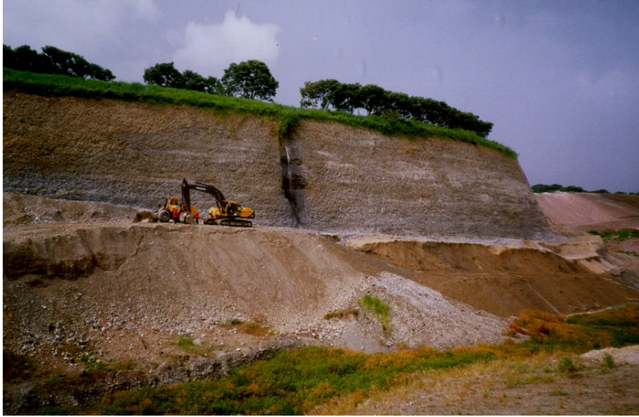
Figura 35. Perfil de una explotación de arena y grava en una terraza aluvial del río Medellín, sector del Valle de Aburrá, ciudad de Medellín. Fotografía: el autor.
