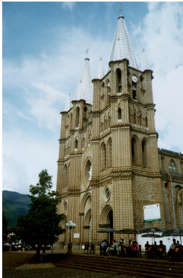
Figura 64. Iglesia de la localidad de Jardín construida totalmente con tobas de la Formación Combia. Fotografía: el autor
