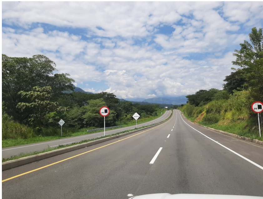
Figura 94. Autopista Medellín – Manizales. Programa de interconexión nacional. Fotografía: el autor
