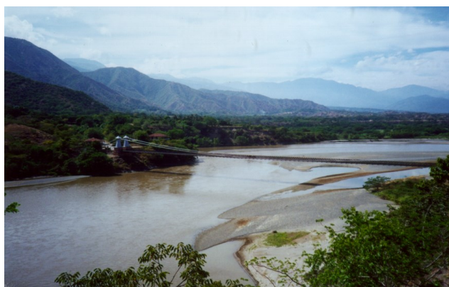
Figura 17. Depósitos de arenas en el Río Cauca, vía Santa Fe de Antioquia – Sopetrán. Fotografía: el autor
