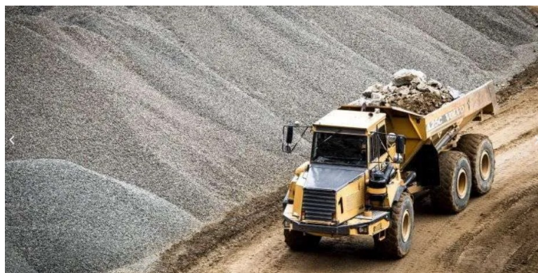
Figura 6. Arriba: Planta de Canteras de Colombia, autopista Medellín – Rionegro. Abajo: Transporte interno del agregado.
