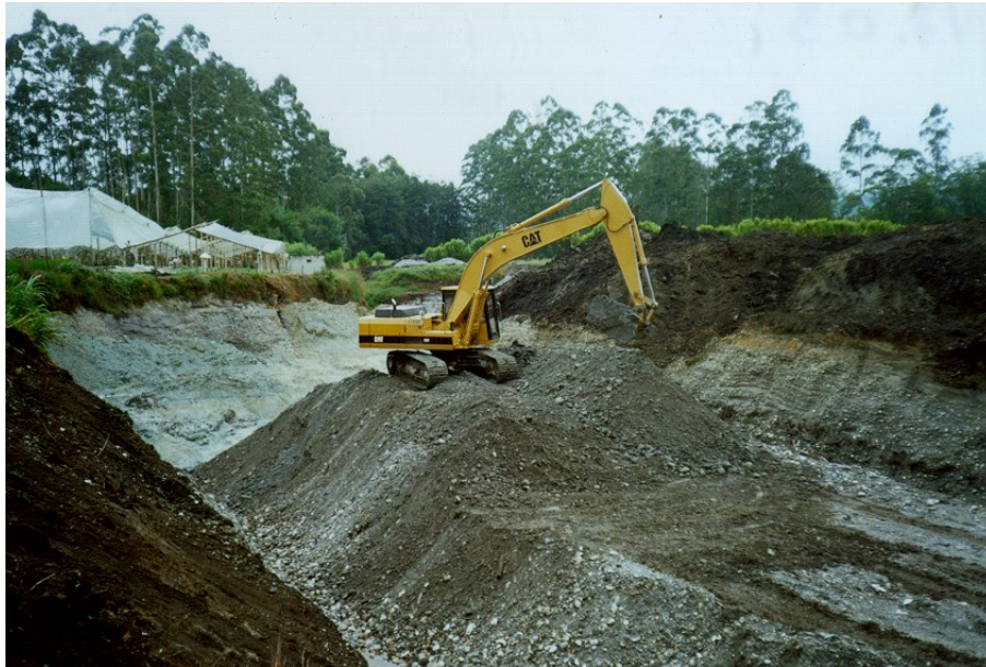
Figura 34. Aluvión en el río Chico, sector de Belmira con abundante material tipo grava gruesa.
