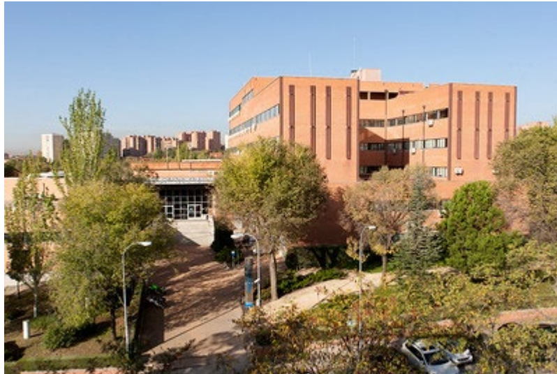
Figura 34. Fotografía exterior del edificio de la ETSITGC de la UPM.
