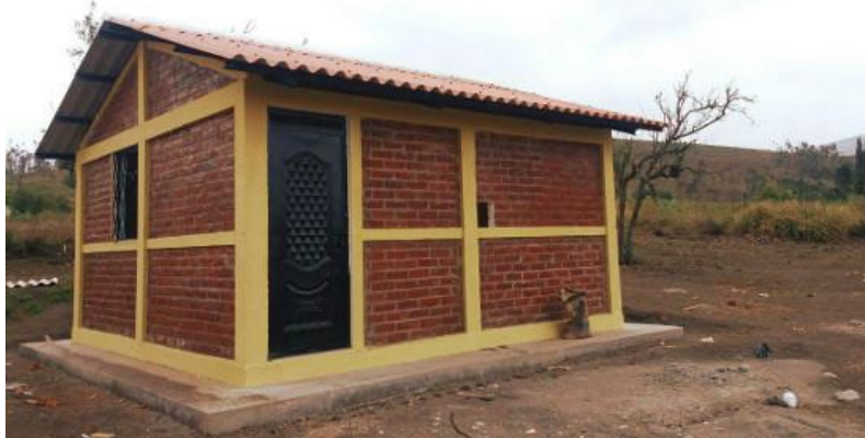
Figura 1. Vivienda tipo de mampostería reforzada en la provincia de Manabí, Ecuador.
