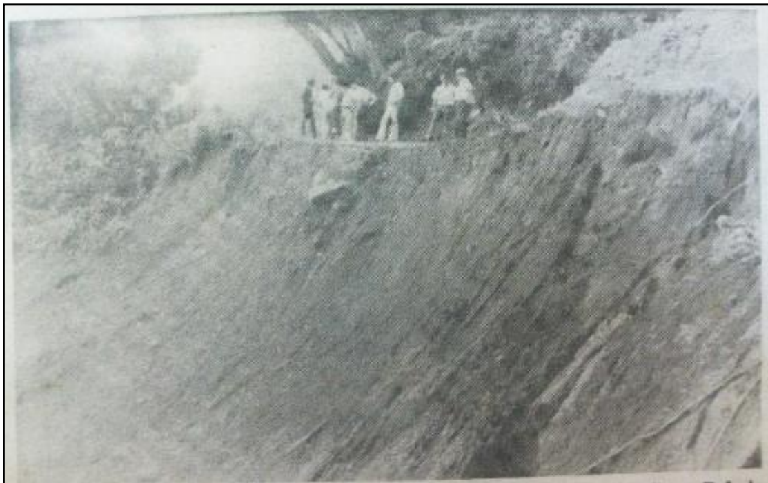
Figura 78. Corona del deslizamiento
