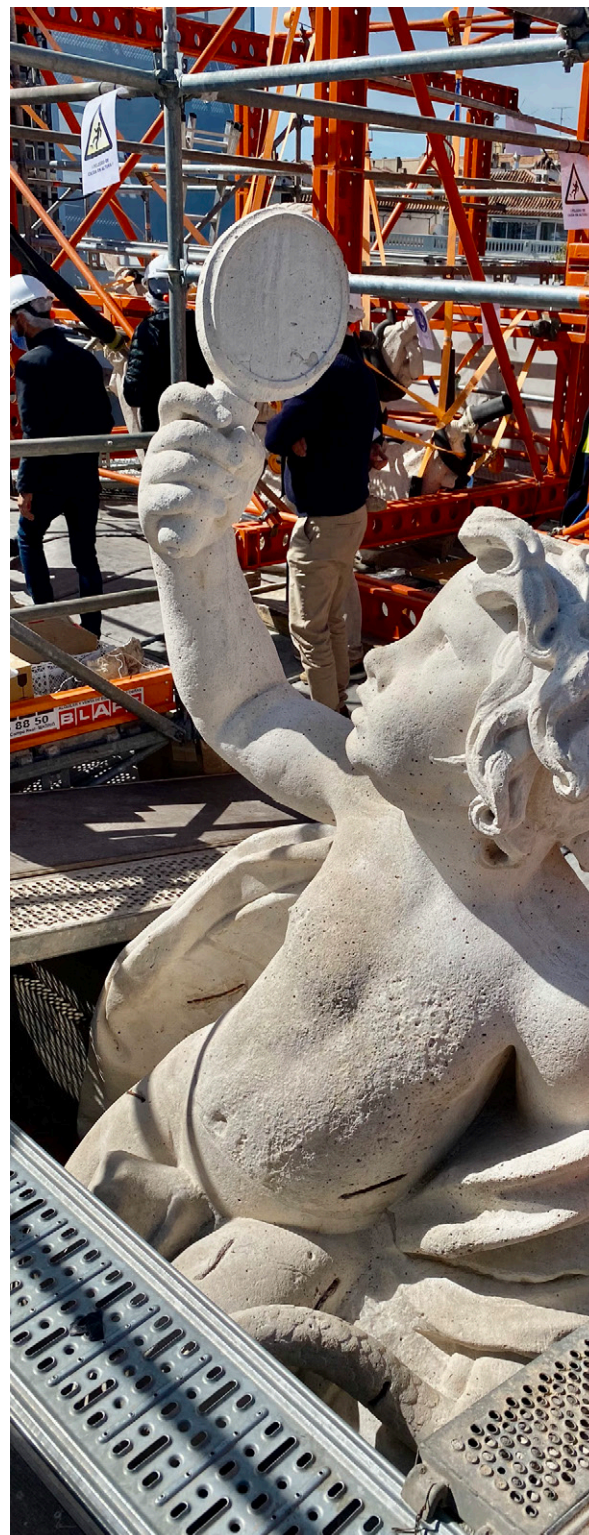
Imagen N° 44. Conservación y restauración del patrimonio en el Paisaje de la Luz,
