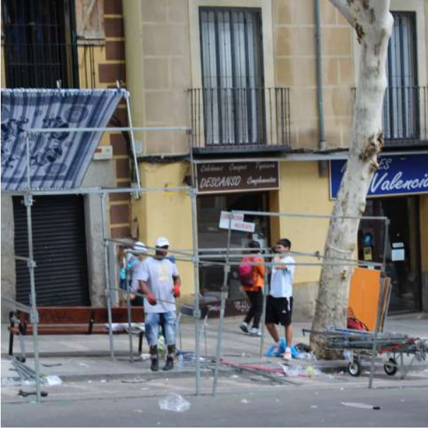
EL DESMONTAJE CALLE RIBERA DE CURTIDORES EL 19/05/2024
