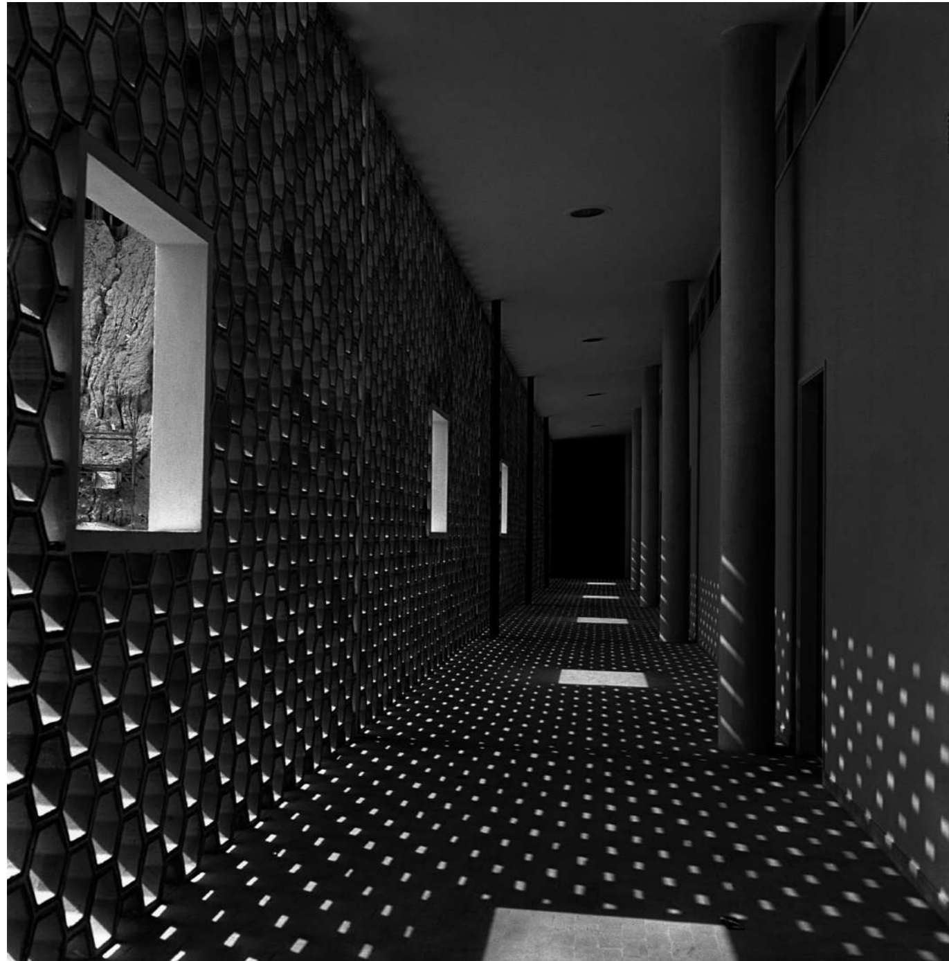
FOTOGRAFÍA 28 _Conjunto Habitacional de Pedregulho proyecto de Affonso Eduardo Reidy, São Cristóvão, circa 1955.
