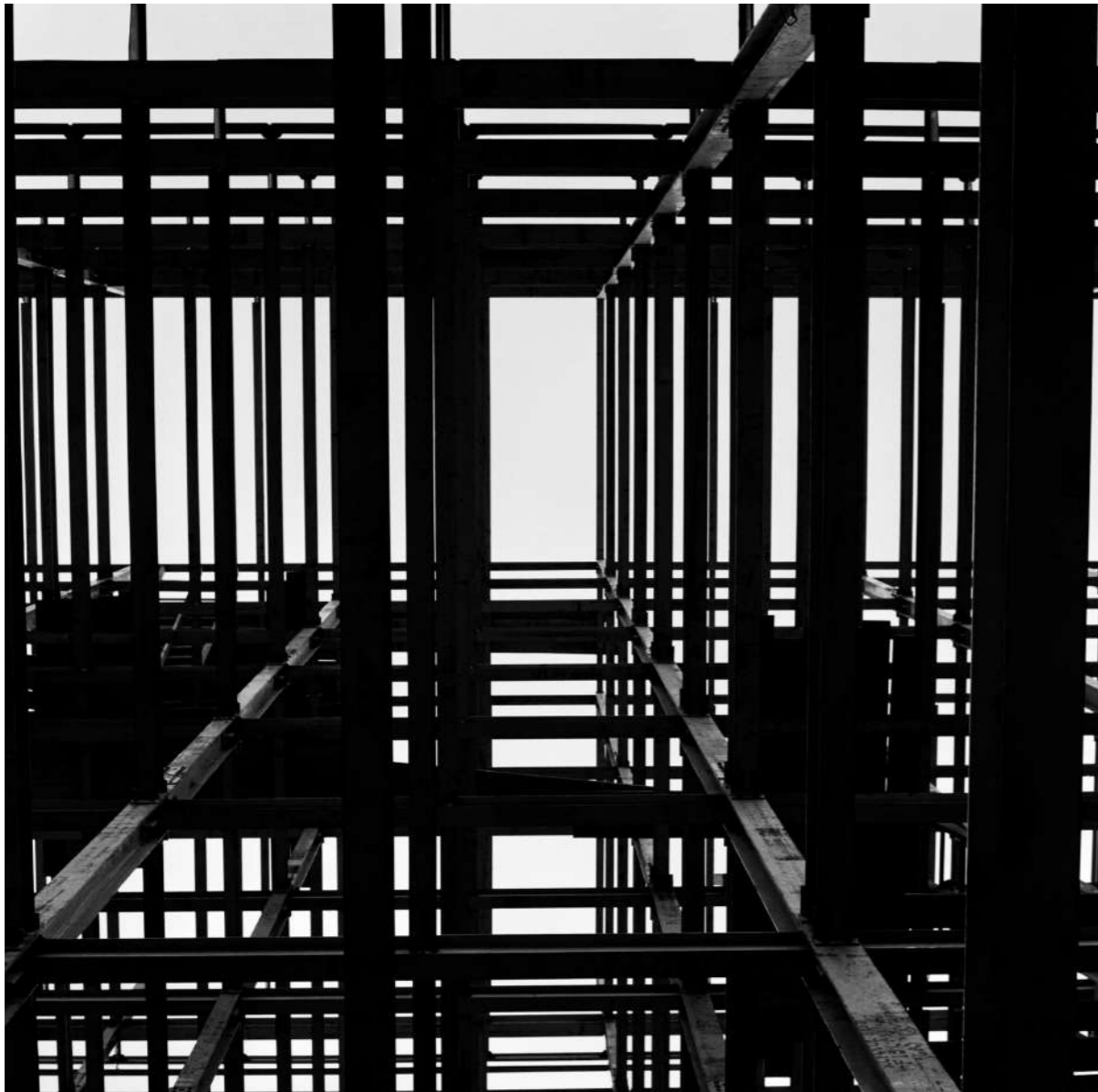
FOTOGRAFÍA 53_Ministerio en construcción, Brasilia, 1959.
