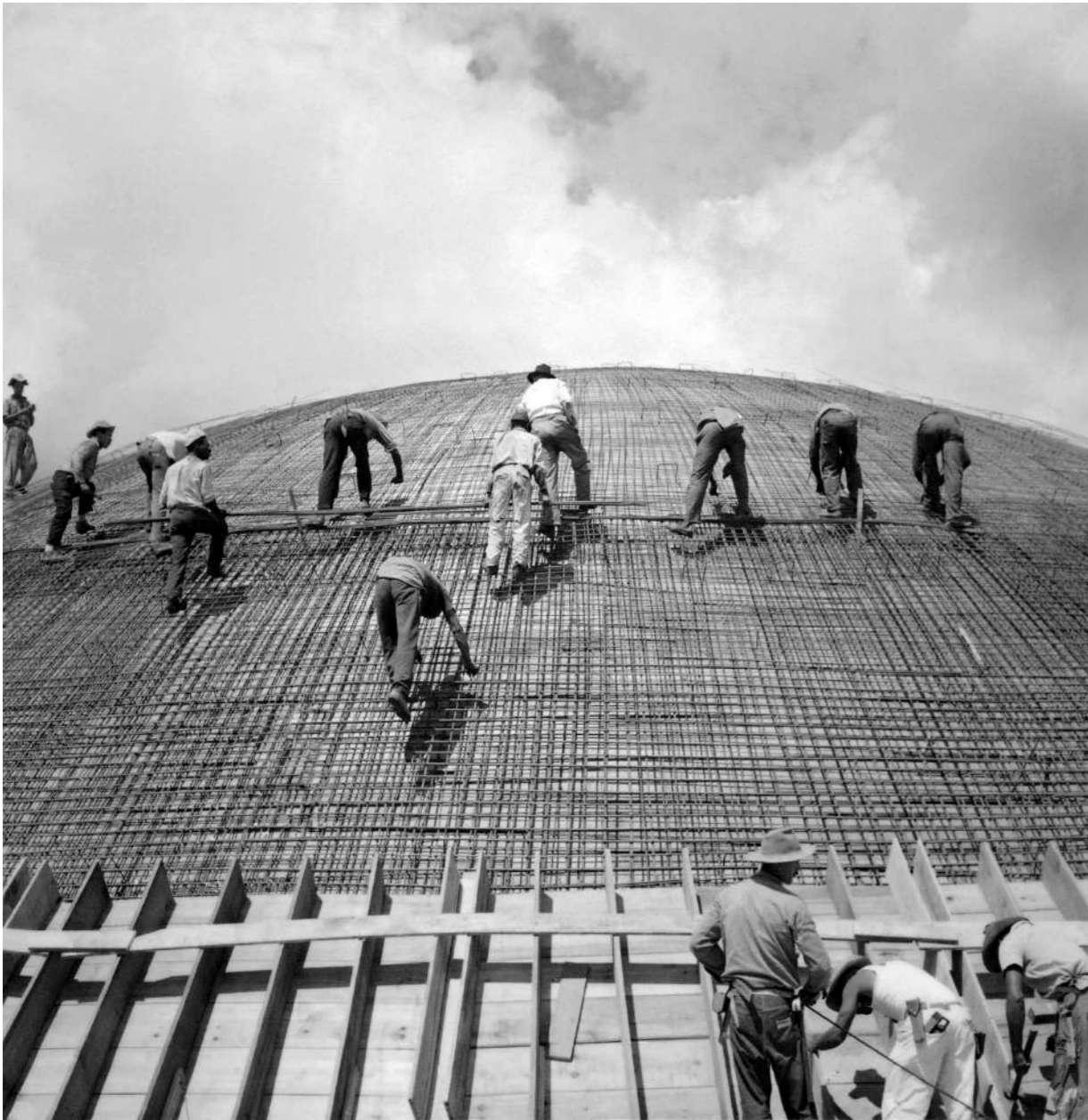
FOTOGRAFÍA 47 _Congreso Nacional en construcción, Brasilia, 1958.
