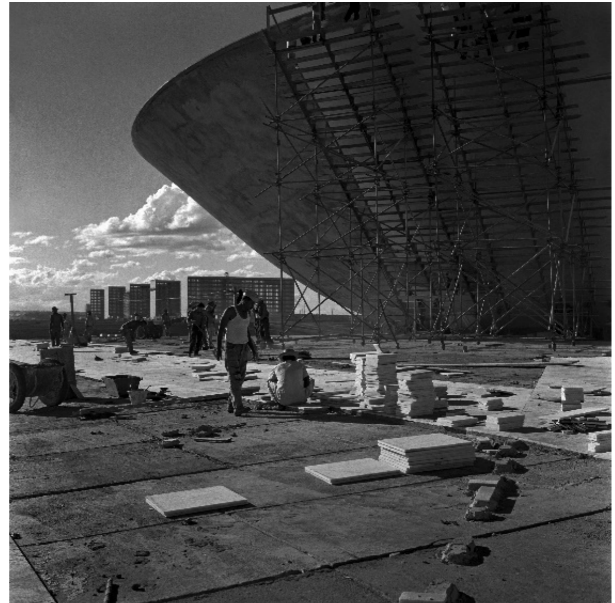
FOTOGRAFÍA 50 _Congreso Nacional en construcción, Brasilia, 1959.
