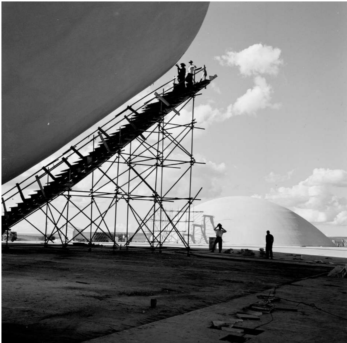
FOTOGRAFÍA 57 _Congreso Nacional en construcción, Brasilia, 1959.
