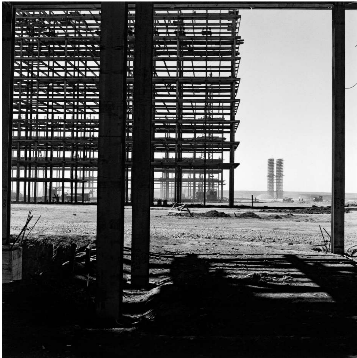
FOTOGRAFÍA 45 _Esplanada de los Ministerios en construcción, Brasilia, 1959.
