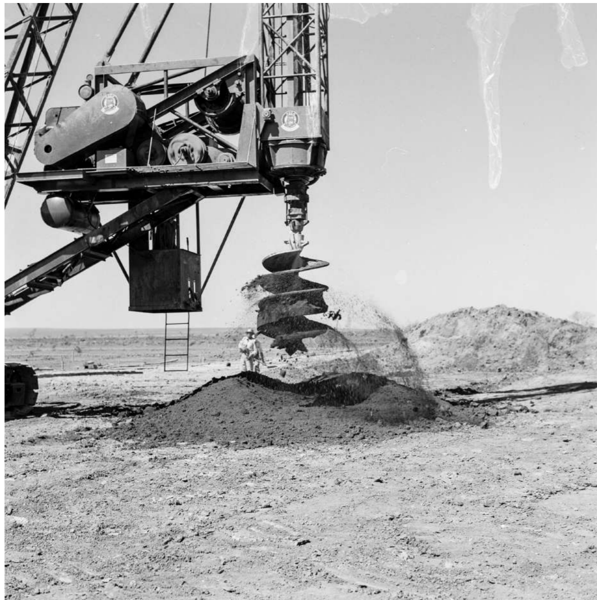
FOTOGRAFÍA 43 _Máquina perforadora, Brasília, 1958.
