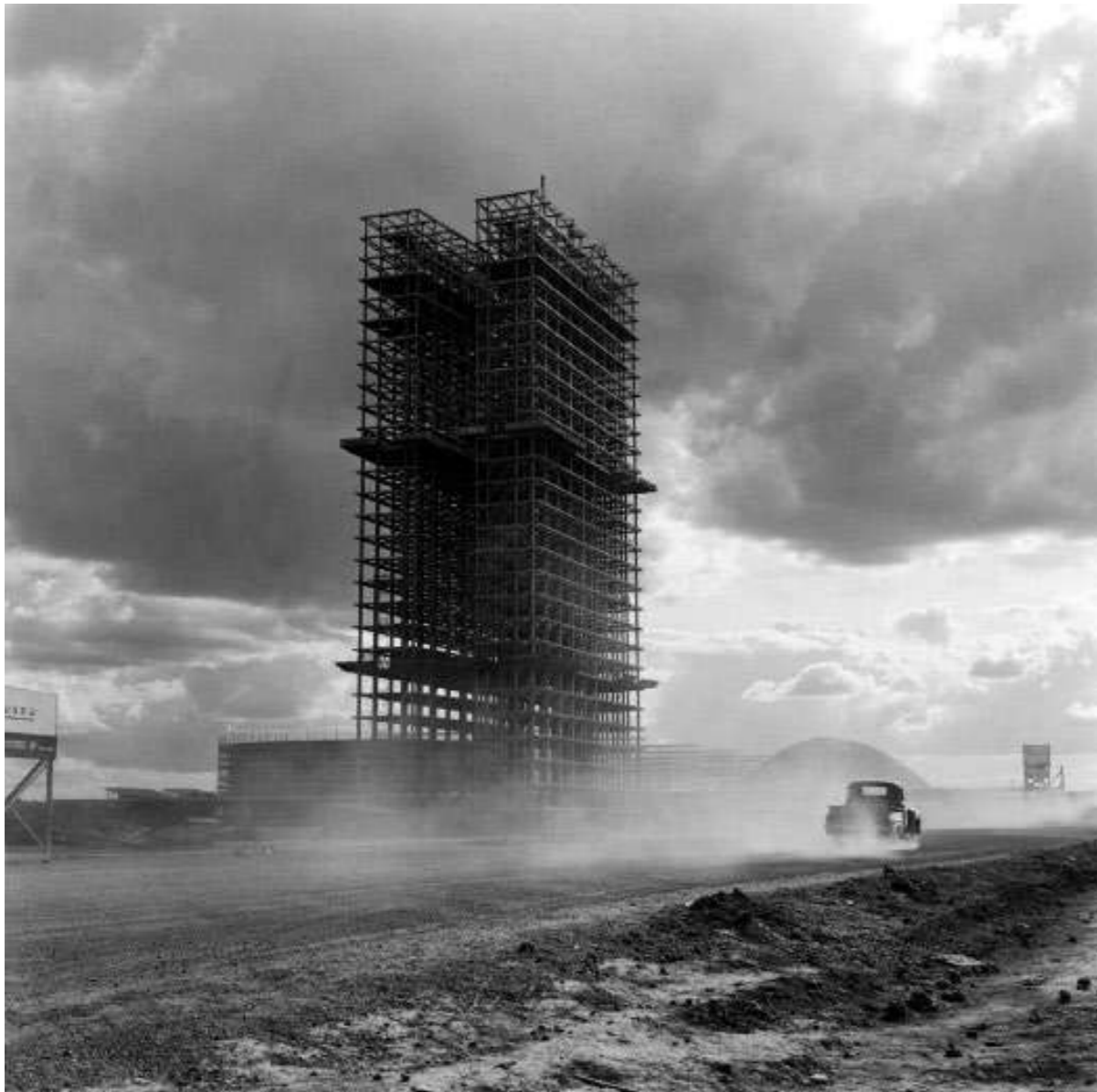
FOTOGRAFÍA 46 _Congreso Nacional en construcción, Brasilia, 1959.
