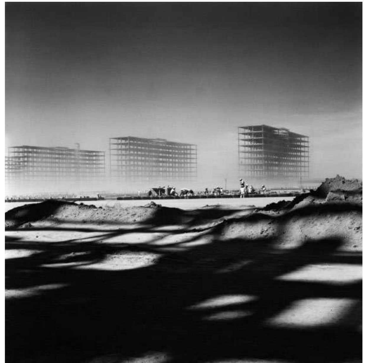
FOTOGRAFÍA 52 _Eje Monumental en construcción, Brasilia, 1959.
