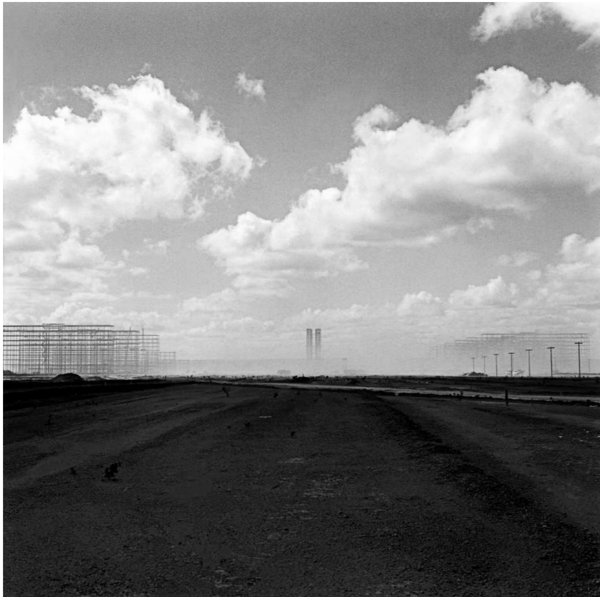
FOTOGRAFÍA 44 _Esplanada de los Ministerios en construcción, Brasilia, 1959.
