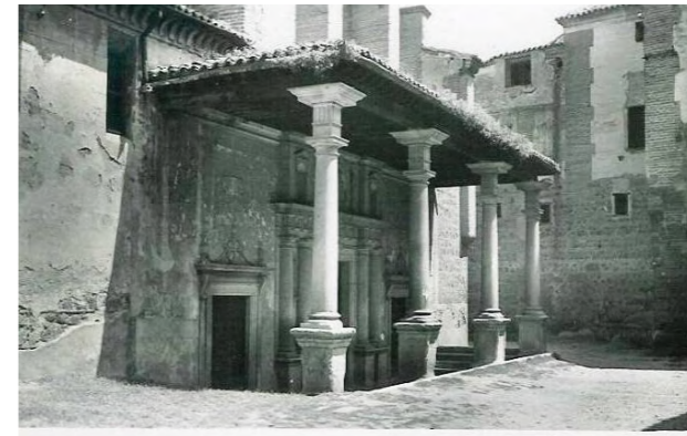
Pórtico de entrada a la iglesia Fig. 2.30
