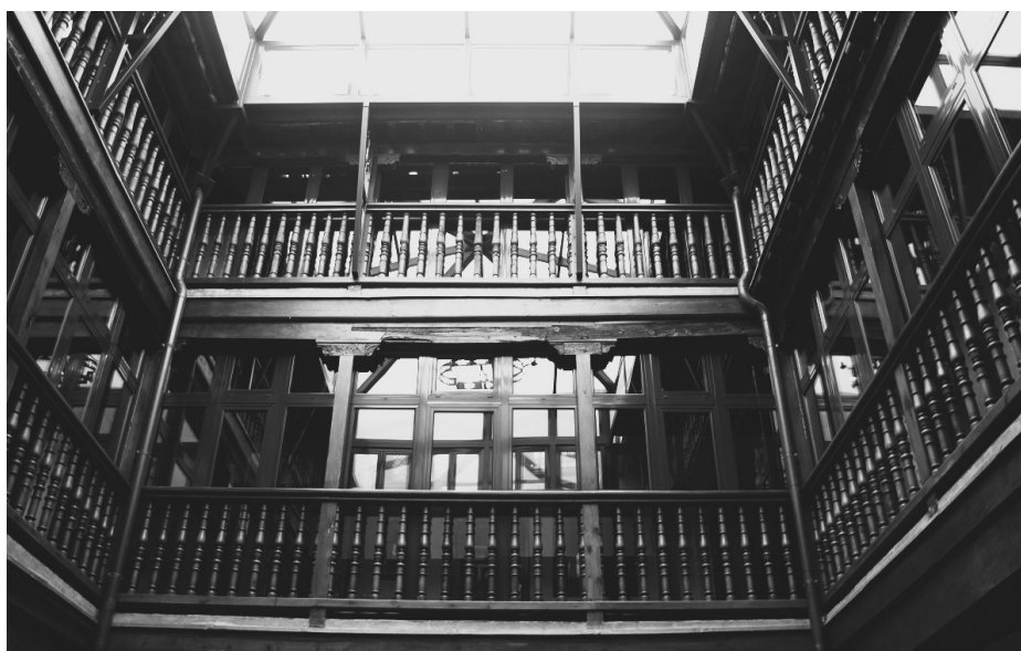
Fig 2.19. Claustro Grande, convento de las Gaitanas
