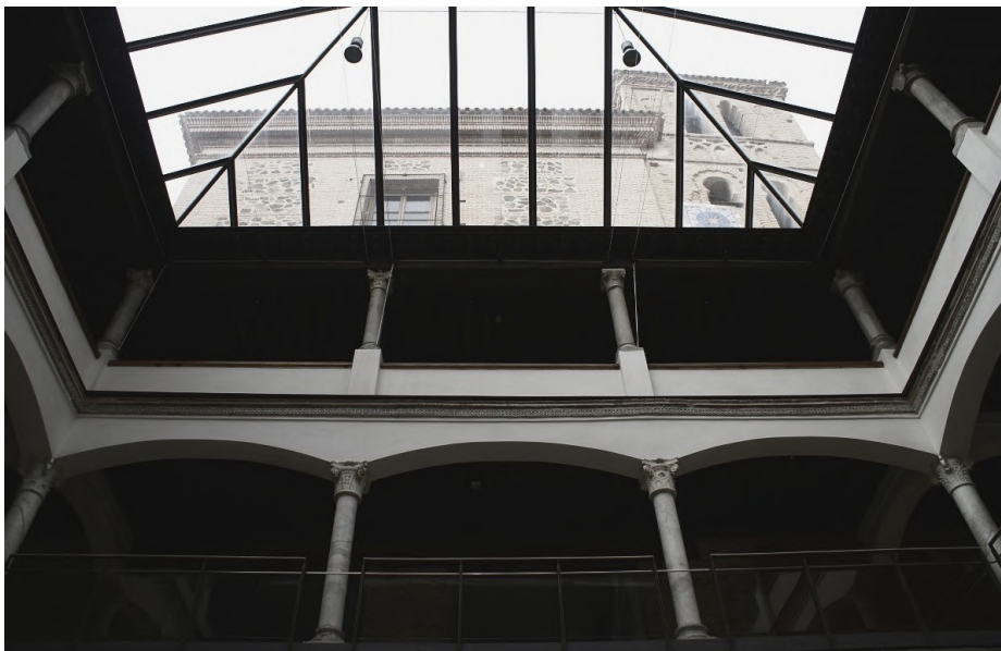
Fig 2.23. Claustro Grande, convento de las Gaitanas
