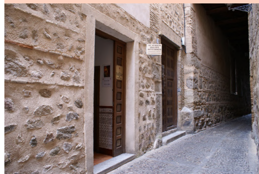
Entrada del convento junto al cobertizo Fig. 2.43
