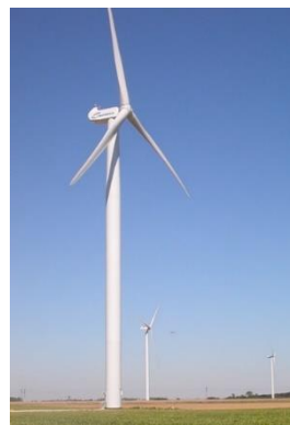
Figura 20. Aerogenerador N90/2500 LS del fabricante Nordex.
