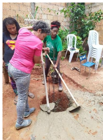
Figura 77: Trazado para formar una zapata y relleno. Fotografías propias.
