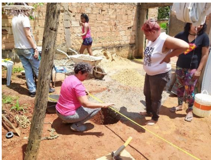
Figura 77: Trazado para formar una zapata y relleno. Fotografías propias.
