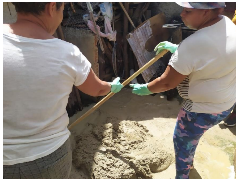
Figura 84: probando la textura necesaria para el reboco. Fotografía propia
