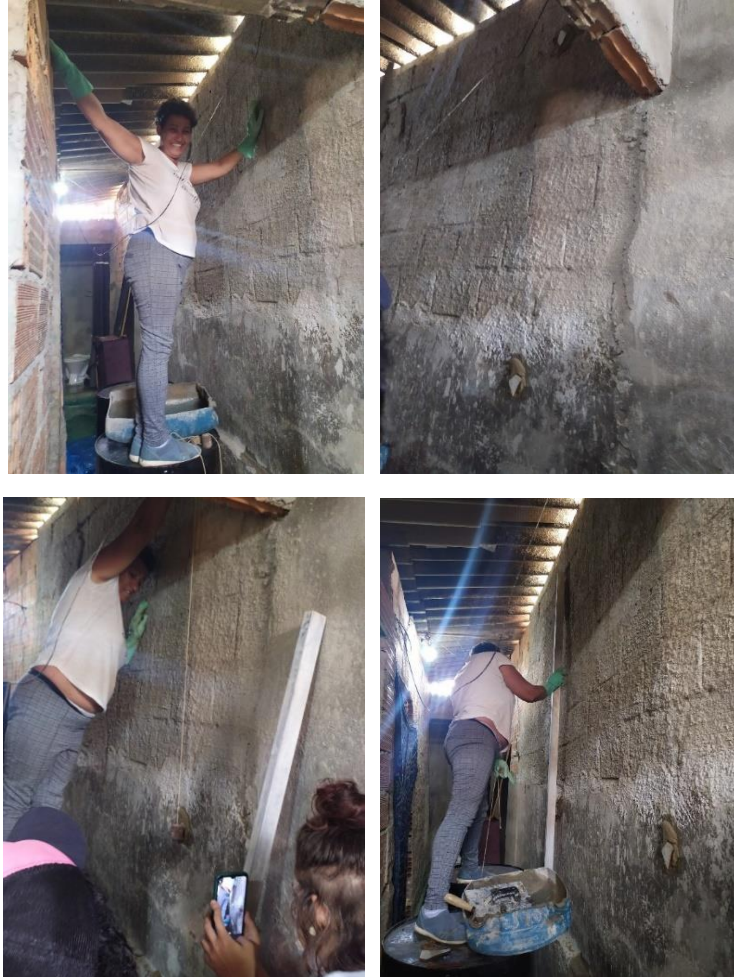
Figura 85: Revocando el muro. Fotografías propias.
