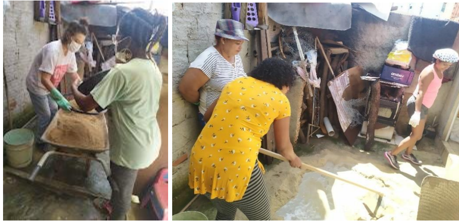
Figura 83: Preparación de la mezcla para reboco. Fotografías propias.
