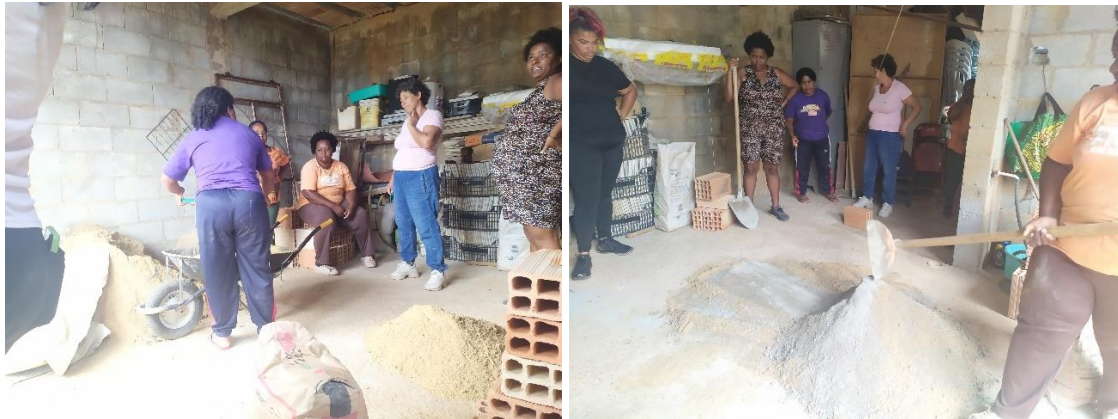
Figura 78: Haciendo la mezcla para la unión de los ladrillos. Fotografías propias.
