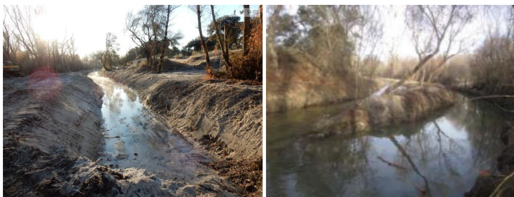
Ilustración 33. Izquierda nuevo brazo del río Manzanares en la confluencia con el arroyo de Trofa, a la derecha confluencia actual del Manzanares-Trofa. Fuente: Fase I Presentación obras restauración fluvial del río Manzanares en el entorno de El Real Sitio de El Pardo
