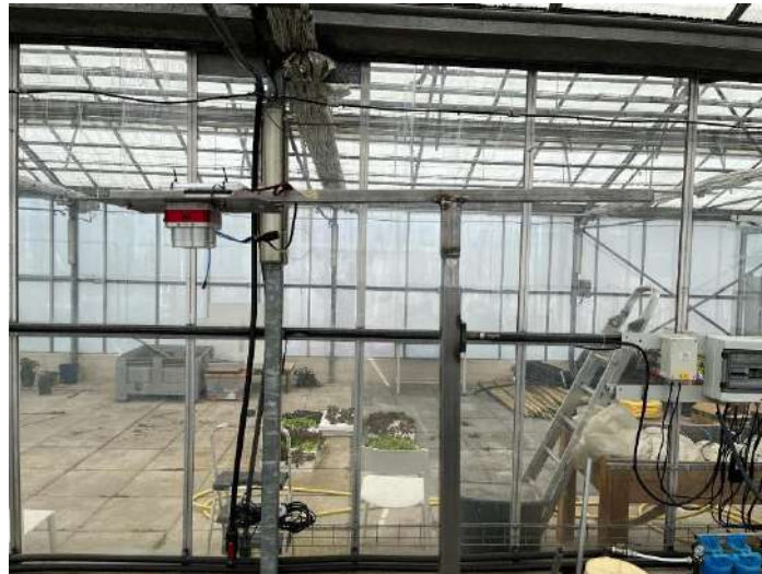
Imagen 11: Soporte Final e Instalado
