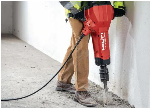
Figura 2: Martillo neumático picando pavimento
