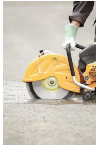
Figura 1: Sierra eléctrica cortando pavimento
