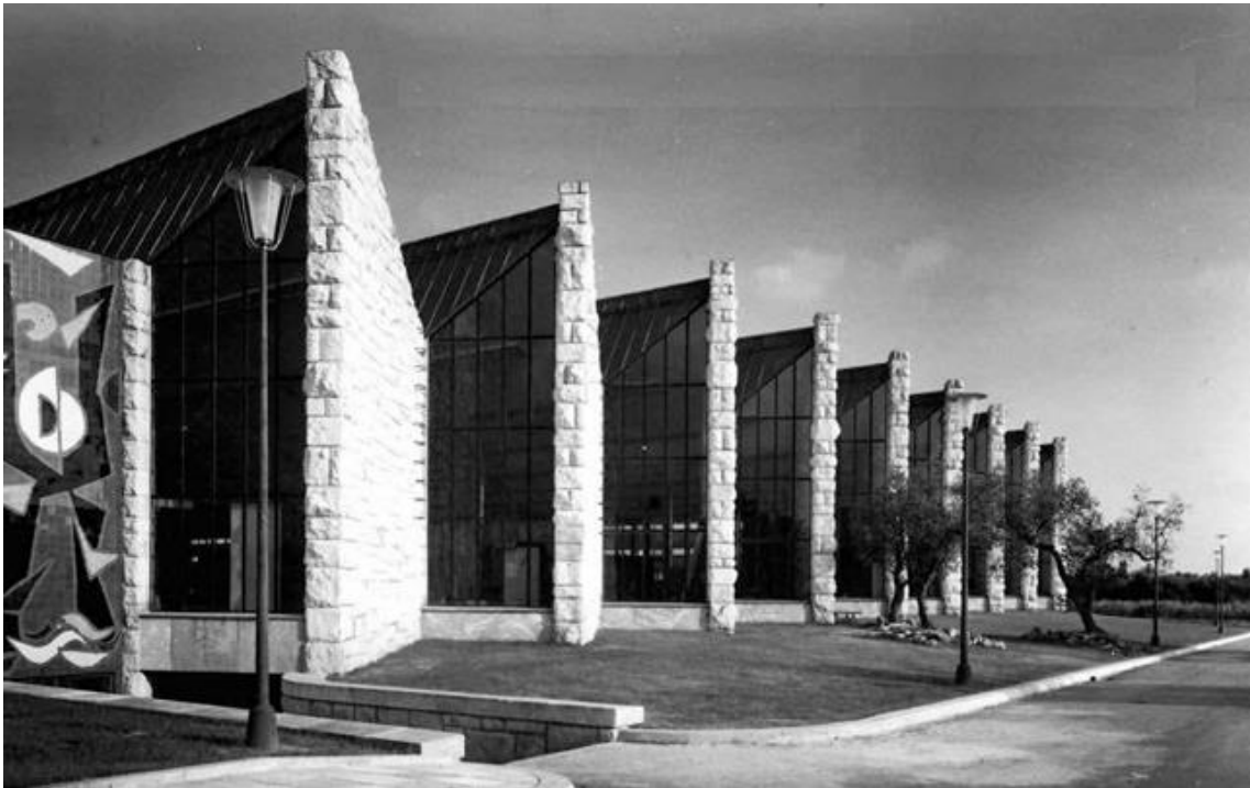
4.15. Fachada lateral de los talleres
