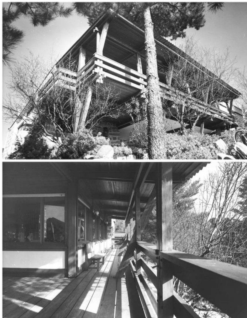
4.27. - 4.28. Solera vivienda unifamiliar Fernández del Amo, El Barraco, Ávila, 1956
