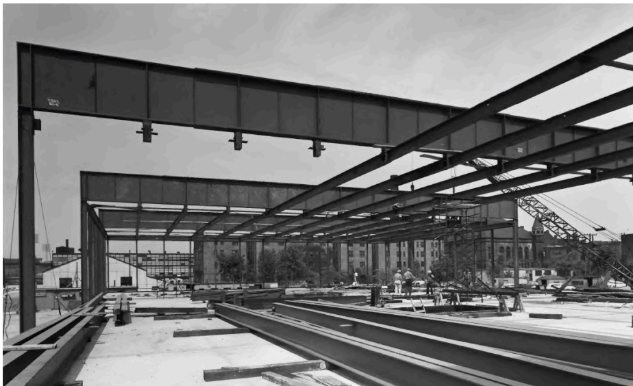
2.5. Estructura del Crown Hall IIT durante su construcción.
