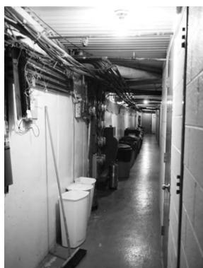
4.39. Pasillo común en el sótano de las viviendas.
