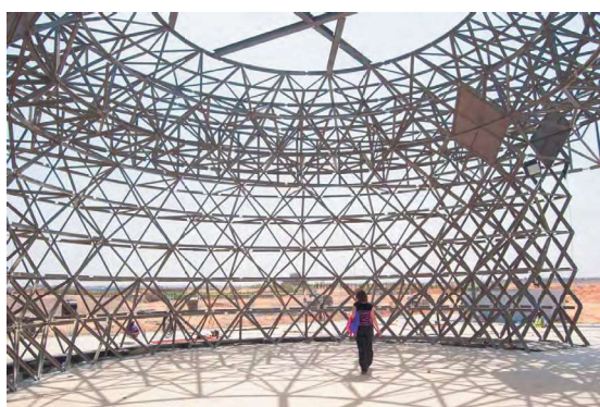
Figura 1. Vista interior del volumen. Retícula estructural triangular metálica.
