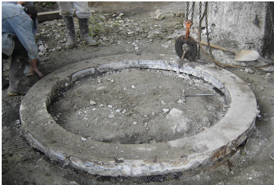
Figura 57. Pérdidas de mercurio por el deficiente armado e instalación de un molino tipo chileno
