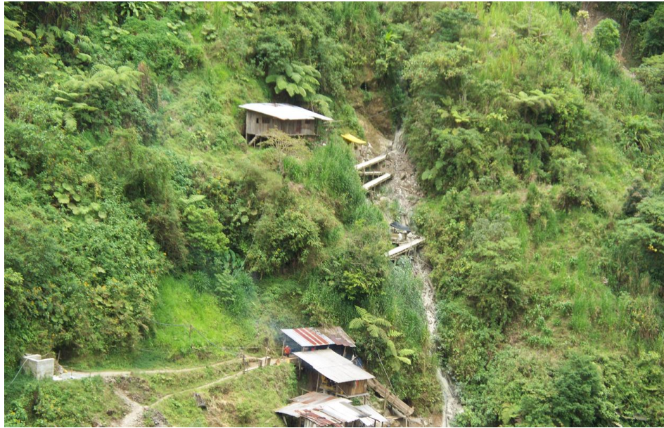
Figura 60. Drenaje secundario, afectado por efluente minero-sanitarios
