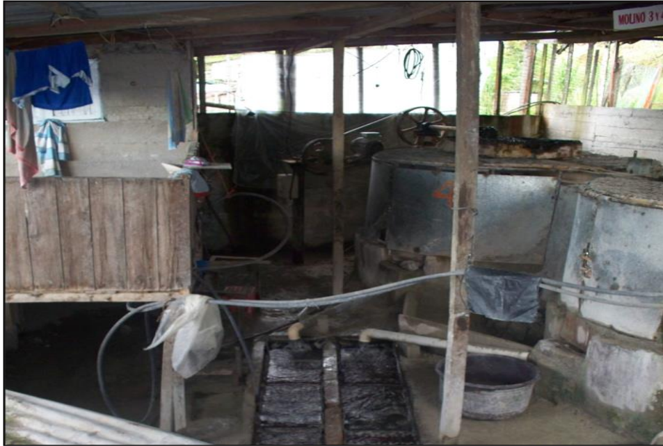
Figura 37. Planta MiningAndos S.A., Sección 2 (molinos 3 y 4); canalón, arena de bayetas
