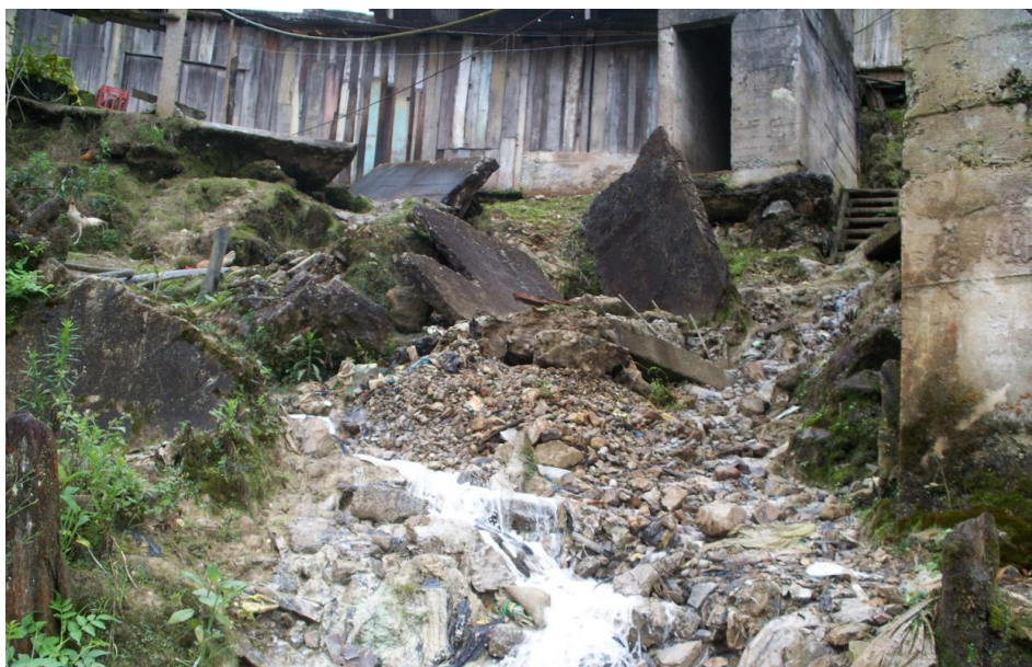
Figura 64. Afluente afectado por el vertimiento de residuos mineros
