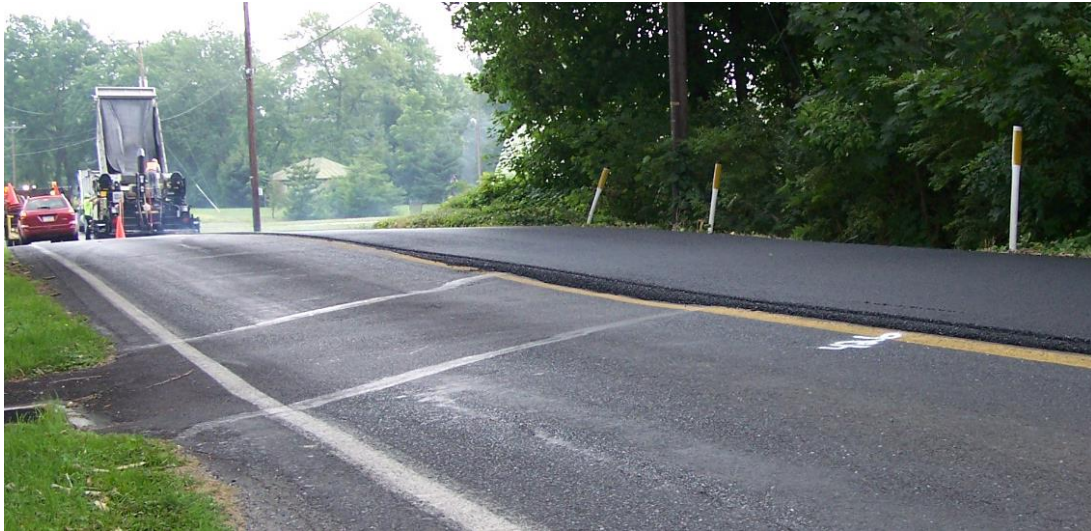
Figura 2.21: Regla de Extendido – Compensación de Irregularidades
