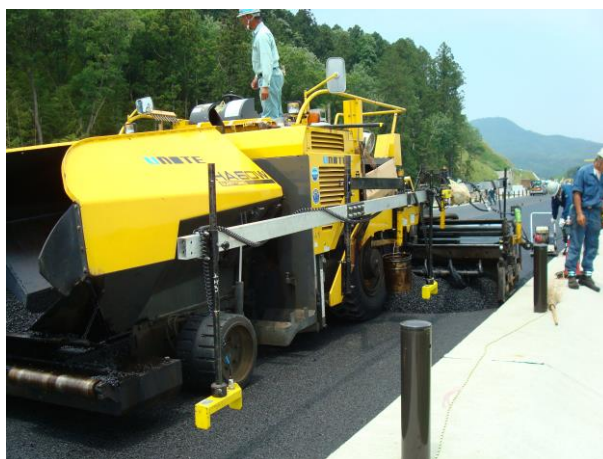
Figura 2.43: Referencia Móvil – Viga Flotante con Sensores Múltiples
