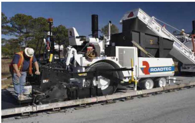
Figura 2.42: Referencia Móvil – Viga con Zapatas de Apoyo
