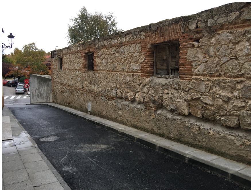
Figura 4.2: Muro de cerramiento escogido para la toma de datos (Madrid, España)
