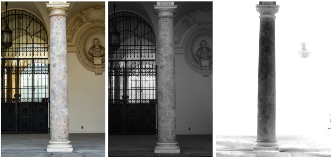
Figura 1.9: Imágenes multispectrales de una columna en el Castello del Valentino (Turin - Italia). (izquierda) Visible (RGB), (central) Infrarrojo cercano (NIR), (derecha) Infrarrojo térmico (IRT). Fuente: [1]
