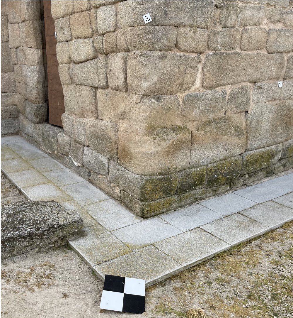
Figura 5.2: Señales en muro y pavimento para posterior georreferenciación
