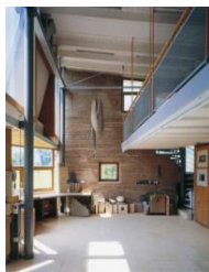
Fig. 12: Interior del Estudio. Estructura de pilares metálicos. Tapial como paramento exterior. Fuente: Pinterest
