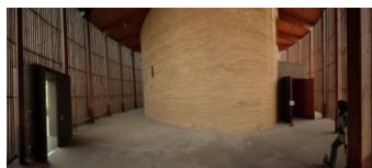
Fig. 14: Tapial interior de la Capilla de Reconciliación Fuente: https://arquitecturayempresa.es/
