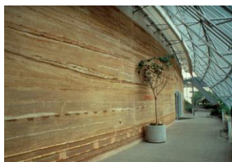
Fig. 13: Interior del Estudio. Estructura de pilares metálicos. Tapial como paramento exterior. Fuente: Pinterest
