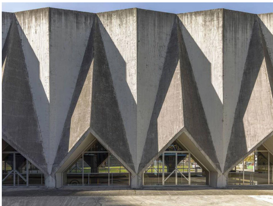
31. Central Hidroeléctrica, Proaza, España. Diseñada por Joaquín Vaquero Palacios, 1964.
