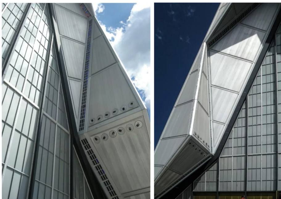
85. Detalle unión vidrio-aluminio.
