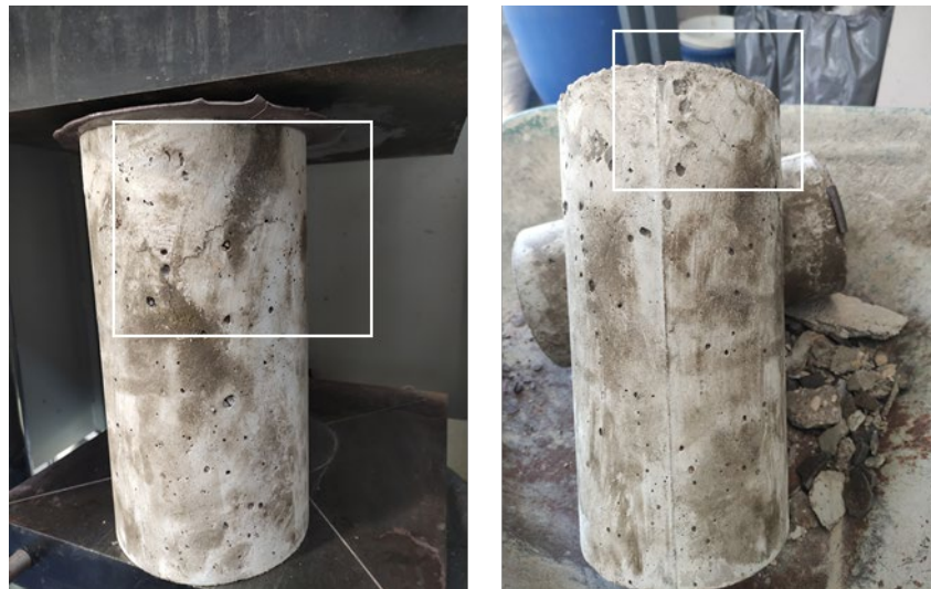
Figura 5.65 probetas de hormigón Z25 con roturas no satisfactorias
