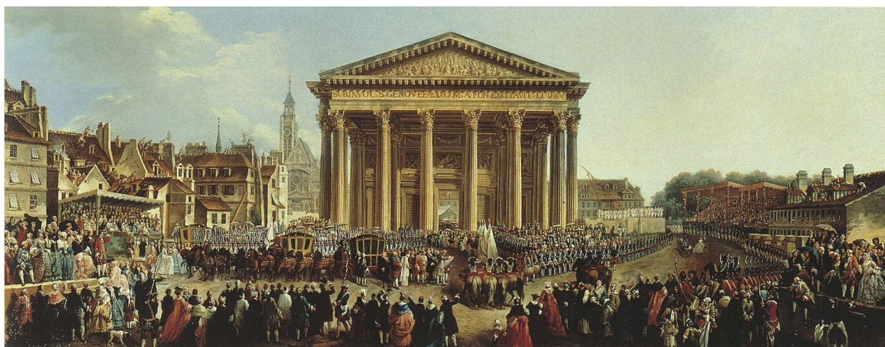
1.12. Cuadro de Pierre-Antoine De Machy representando la colocación de la primera piedra el 6 de septiembre de 1764
