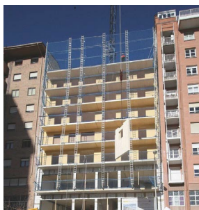
Figura 35. 01. Residencia en Azpilagaña, el edificio más alto proyectado, en construcción
