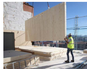
Fig. 02. Paneles prefabricados de madera contralaminada en la obra de Residencia en Azpilagaña
