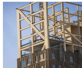
Fig. 08. Estructura de GLT en Mjøstårnet, Noruega
