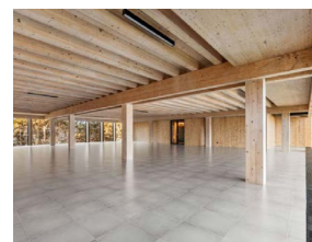
Fig. 14. Edificio Wittywood, Barcelona, con estructura de entramado pesado
