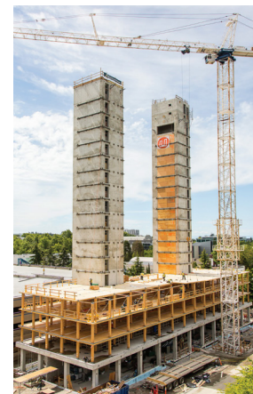
Fig. 21. Núcleos de hormigón en Brock Commons, Vancouver
