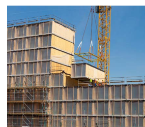
Fig. 16. Construcción del Hotel Jakarta, en Ámsterdam, con módulos volumétricos prefabricados
