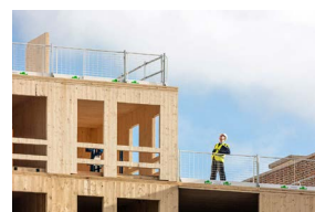
Fig. 15. Sistema de paneles en Dalston Works, Londres
