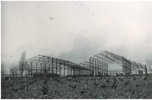
Figura 24. Estructura metálica del Museo de Máquinas o Estación de Motocultura, en su emplazamiento original junto a la Casa de Labor. Al fondo se encuentran los talleres de carpintería. S. f. Fuente: Fondo fotográfico ETSI Agronómica, Alimentaria y de Biosistemas. UPM.
