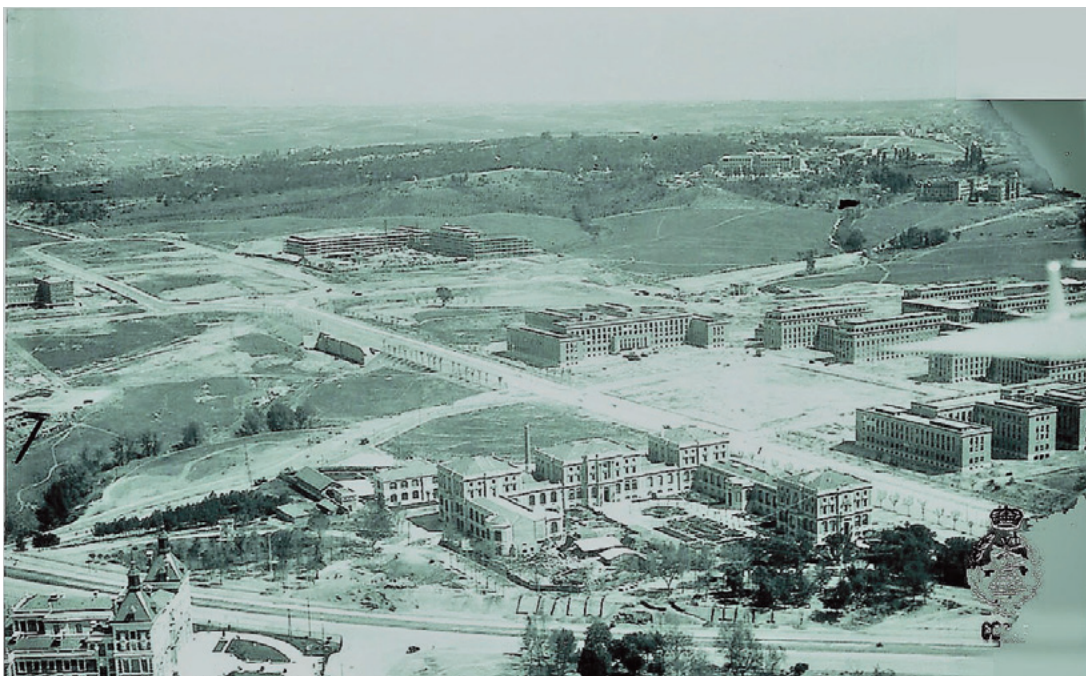
Figura 3. Escenario alrededor del edificio principal de la EIA, aún no terminado hacia 1934, pero ya con el detalle de la traza de la nueva autopista que divide al futuro campus universitario, separándolo de su campo de prácticas, una herida en primer plano que se anticipó a otras en el de campo de batalla a partir de 1936. Fuente: CECAF.
