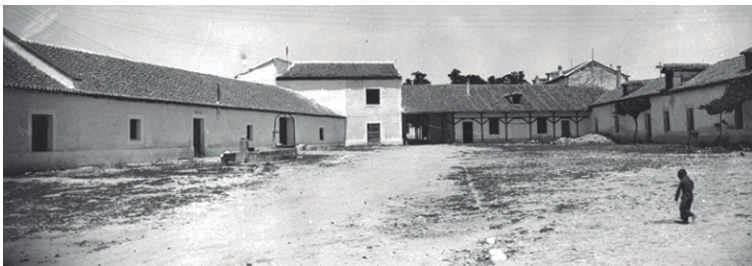
Figura 41. Fotografía tomada en el patio sur de la Casa de Labor, mirando hacia el norte. Fuente: Fondo fotográfico de la ETSI Agronómica, Alimentaria y de Biosistemas. UPM.
