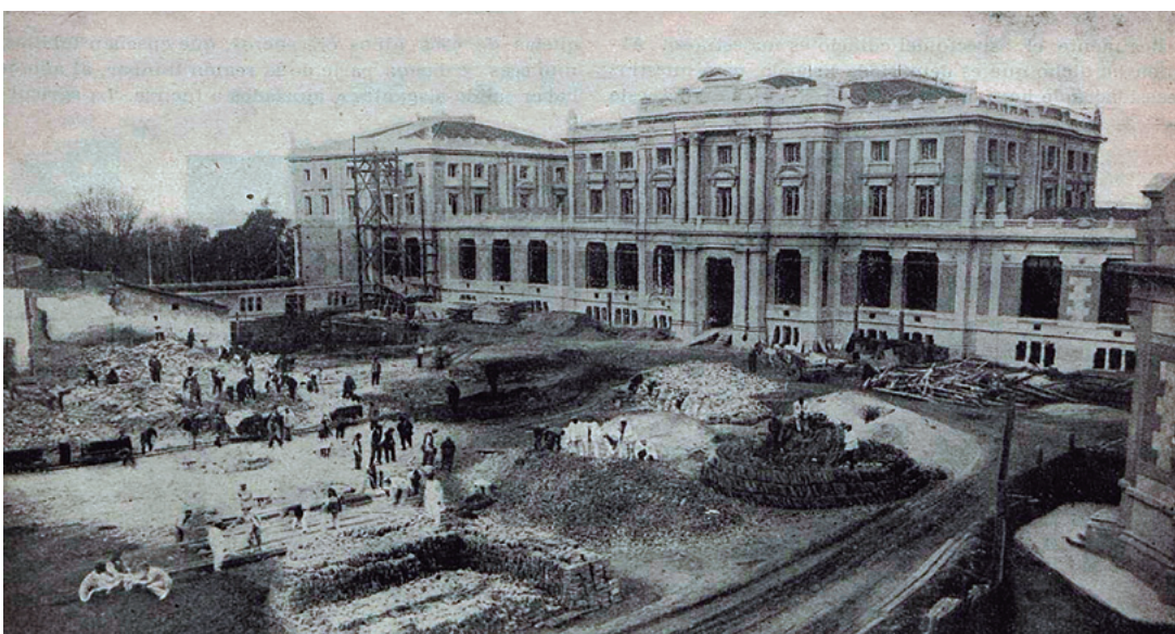
Figura 14. Escuela de Agrónomos en construcción. Pueden verse aún, a la izquierda, los últimos restos del edificio antiguo. Fuente: El Progreso Agrícola y Pecuario , 15 de abril de 1928. Hemeroteca Digital. Imágenes procedentes de los fondos de la Biblioteca Nacional de España. BNE CC-BY 4.0.
