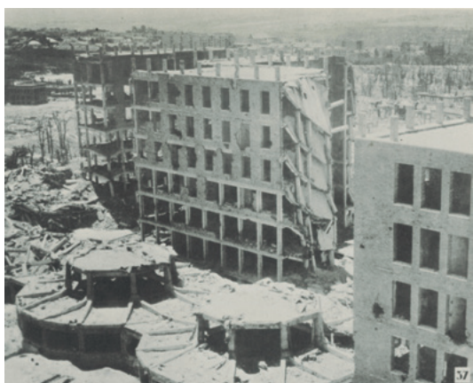
Figura 20. Daños en la estructura de hormigón del Hospital Clínico debidos a los efectos de las minas. Fuente: Universidad Complutense de Madrid, "La Ciudad Universitaria de Madrid", 1943.
