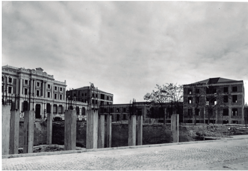
Figura 41. Construcción del ala este, antes del forrado de las fachadas. Aún se mantenía la cota original del patio de entrada. Fuente: Fondo fotográfico de la ETSI Agronómica, Alimentaria y de Biosistemas. UPM.
