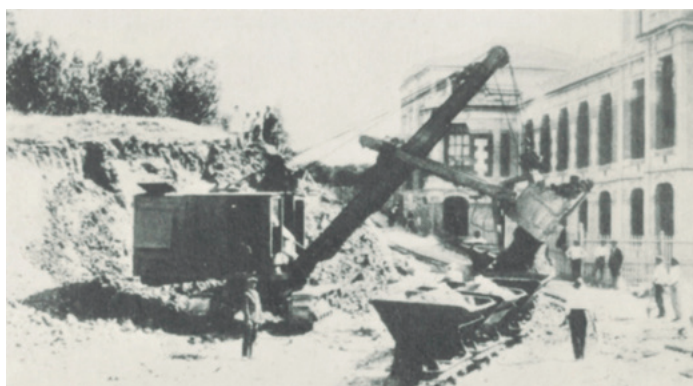
Figura 17. Maquinaria empleada en el movimiento de tierras, 1929: locomotoras y palas Bucirus. Fuente: AGUCM, D-1712.
