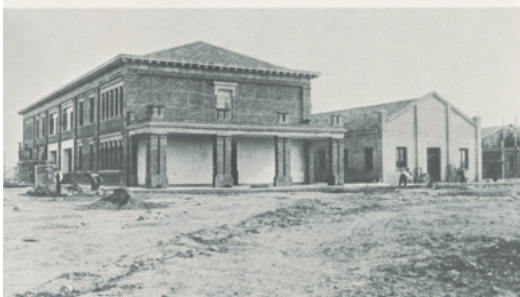
Figura 4. Los quince pabellones Docker en 1929 que junto a otros edificios no provisionales se construyeron en los terrenos de la Ciudad Universitaria. Por su doble función docente y asistencial constituyeron el germen de la Facultad de Medicina. Fuente: Oficina de Obras, Universidad Complutense de Madrid.
