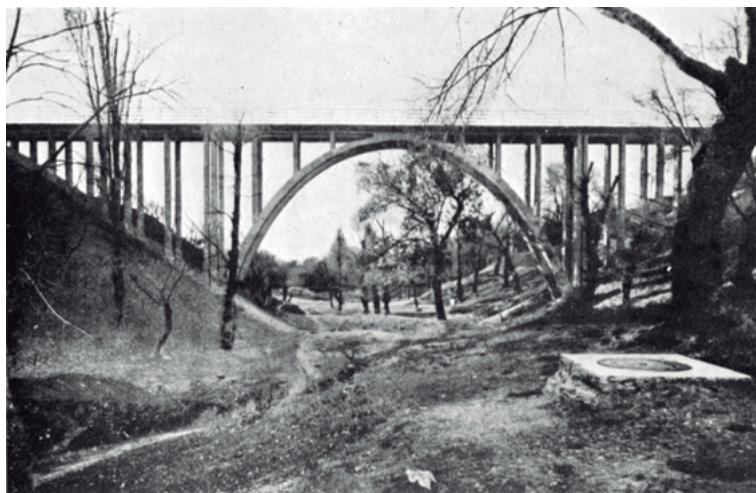
Figura 12. Eduardo Torroja, 1929: el Viaducto del Aire, hoy enterrado. Fuente: Revista de Obras Públicas (1935), 2675, p. 303.
