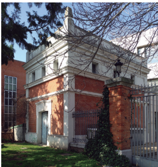
Figura 10. Estado actual del pabellón del transformador. Fuente: Fotografía de Jara Muñoz.
