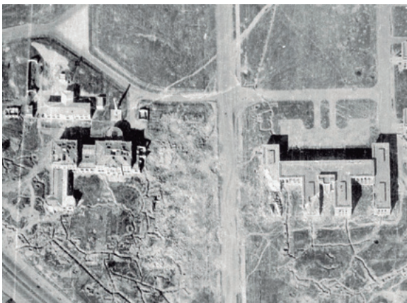
Figura 12. Imagen aérea del estado en que quedó el edificio principal de la EIA., otro símbolo a la memoria por mitades para cada contendiente. Archivo de Cuatro Vientos, Ministerio de Defensa. Tomada de Losada et al. (2006). Disponible en: https://www.ub.edu/geocrit/b3w-678.htm . Fuente: España. Ministerio de Defensa, AGMAV, F.123,44.
