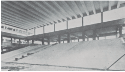
Figura 14. Carlos Fernández Casado, 1934: Aula Magna de la Facultad de Ciencias durante su construcción. Fuente: Oficina de Obras, Universidad Complutense de Madrid.
