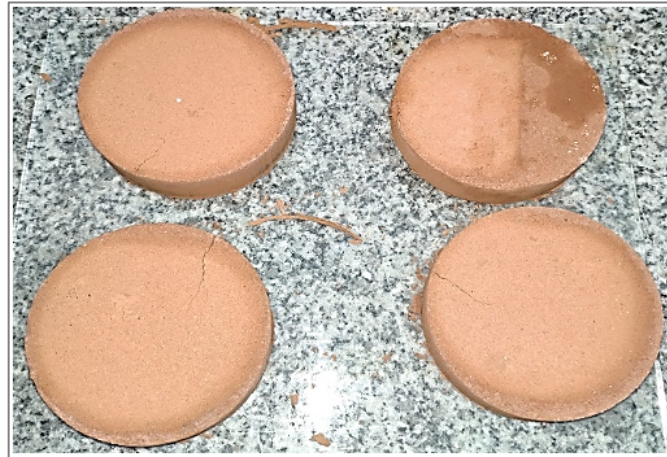
Figura 46. Fisuras generadas por exceso de temperatura de curado
