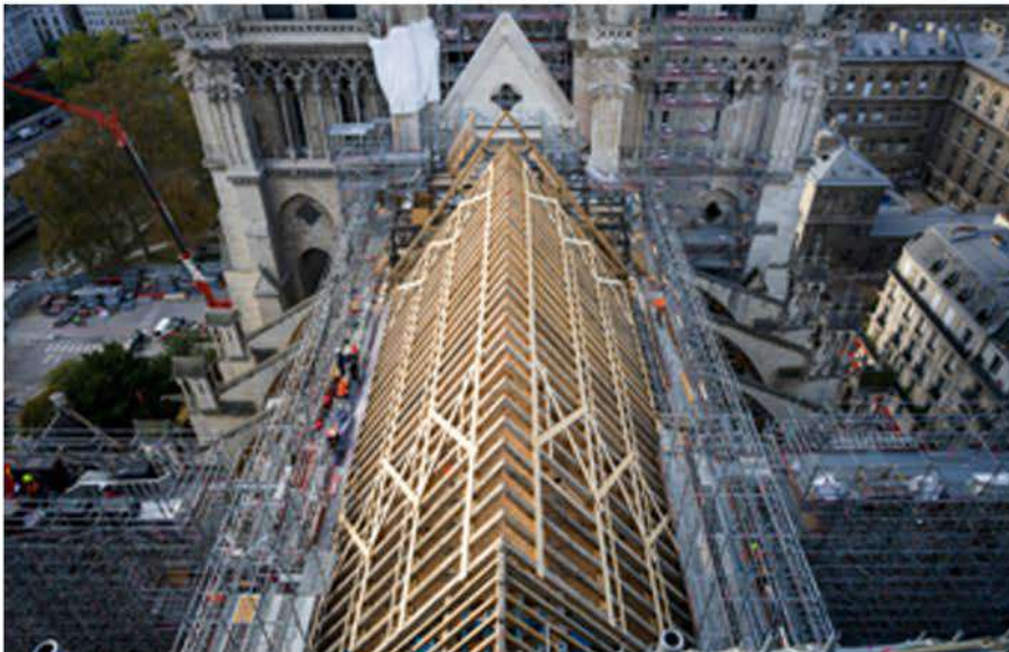
Imagen 21. Estructura de madera de la cubierta de Notre Dame
