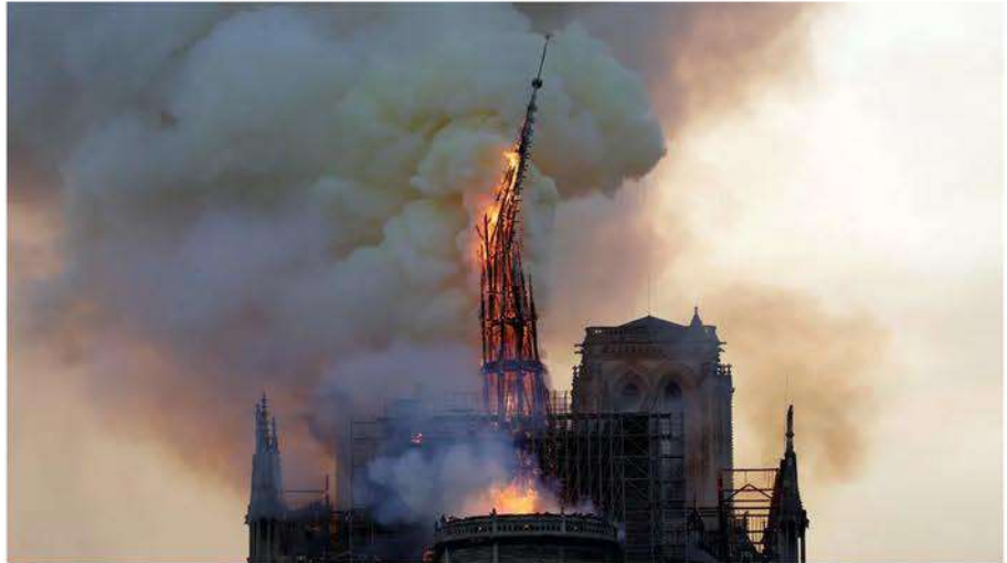
Imagen 13: Colapso de la aguja durante el incendio, 2019
