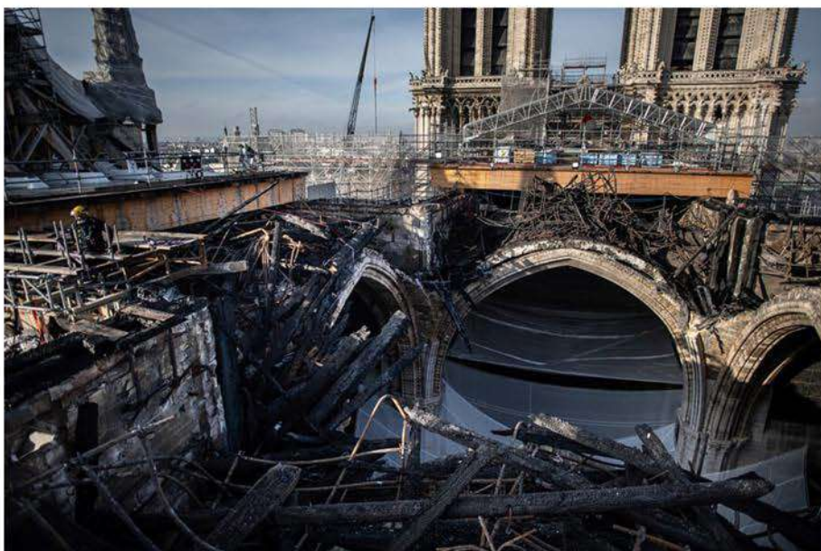
Imagen 12: Colapso de la cubierta durante el incendio, 2019
