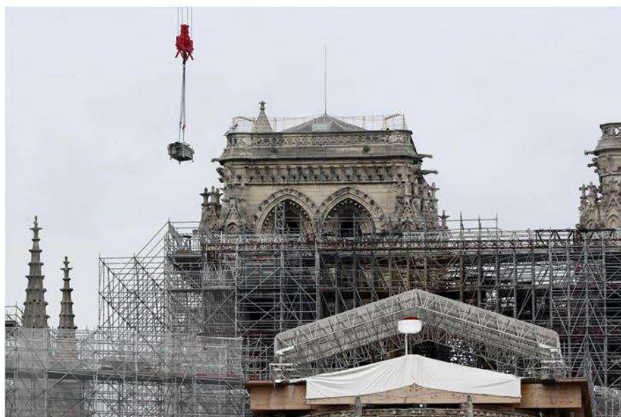
Imagen 20: Trabajos de restauración en la cubierta
