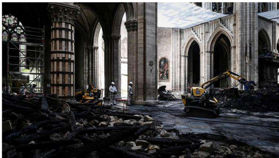
Imagen 19: Trabajos en el interior de la catedral
