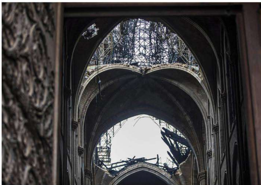
Imagen 15: Derrumbe de la bóveda del crucero, 2019
