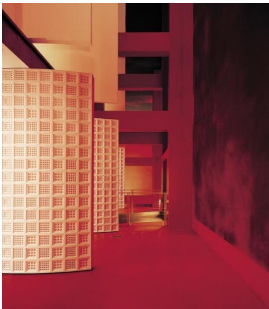
Fig. 49. Interior de la cámara de eco y vista del relieve de yeso de las paredes de la sala.
