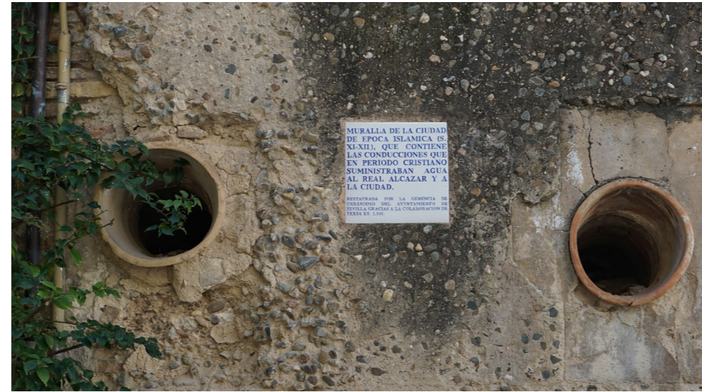
[9] Imagen de las canalizaciones almohade (derecha) y renacentista (izquierda) que abastecieron a los Reales Alcázares hasta el siglo XX. Imagen tomada por la autora.
