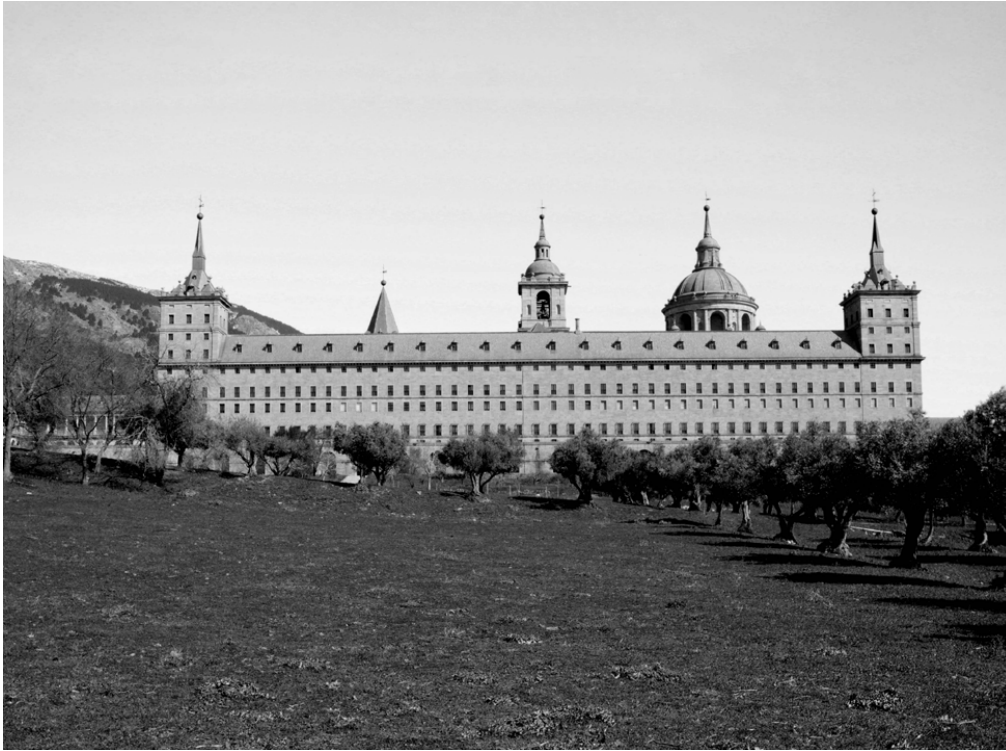
Figura 16. Vista del alzado sur del monasterio desde los cuarteles de las huertas. Elaboración propia.
