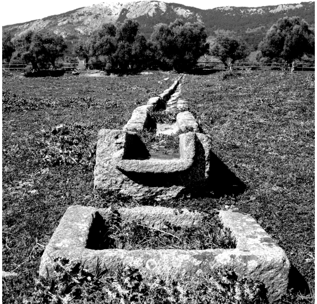
Figura 21. Final del tramo de conducción de riego ubicado en el extremo este de las huertas. El segmento finaliza en una pila de piedra labrada. Elaboración propia.
