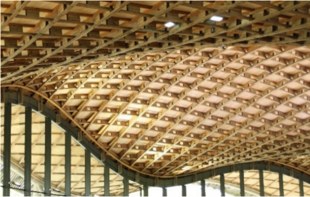
[Fig. 1.12] Curvado de lámina en obra (dcha.).
