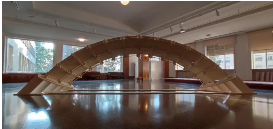
[Fig. 0.01] Estructura laminar reticular de madera deformada elásticamente. Taller Experimental. Primavera 2023.
