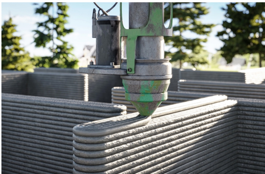
Fig. 2.6: Impresión 3D con cemento en obra. Fuente: ultracem
