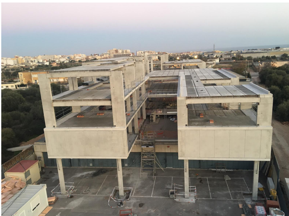
Fig. 1.6: Montaje en obra de una estructura prefabricada. Fuente: Hermo
