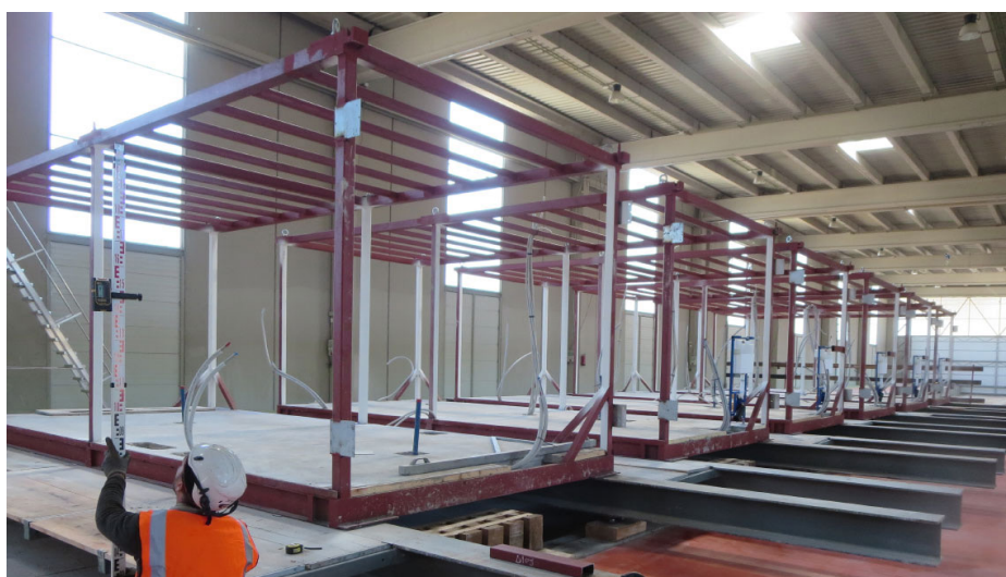
Fig. 1.1: Montaje de una vivienda en fábrica. Fuente: Compact Habit
