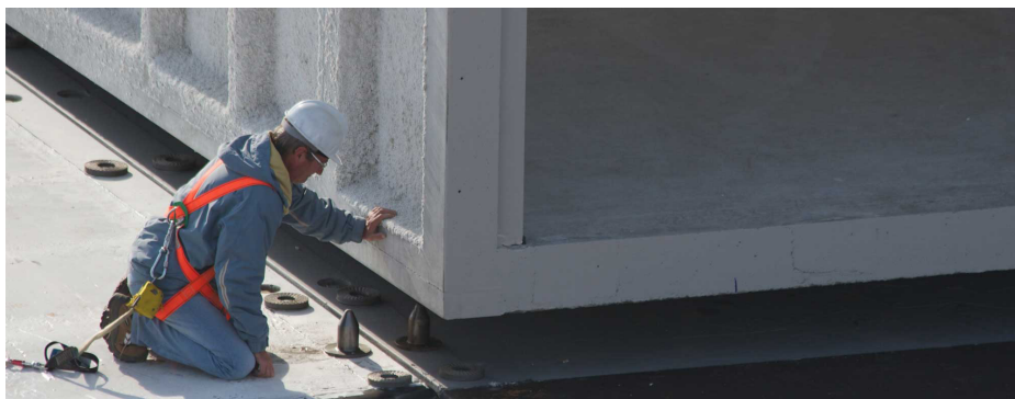
Fig. 4.13: Imagen de la unión del módulo en obra. Fuente: Compact Habit
