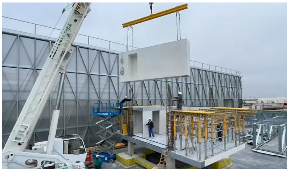
Fig. 4.1: Montaje de paneles en el laboratorio de woho
