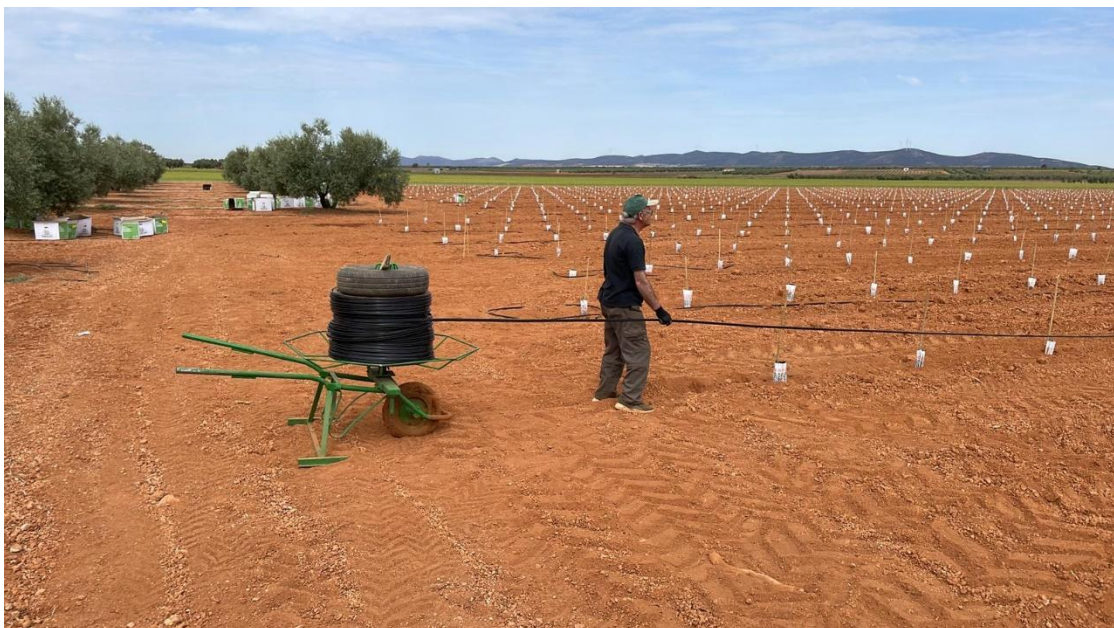
Ilustración 6 Instalación de portagoteros.
