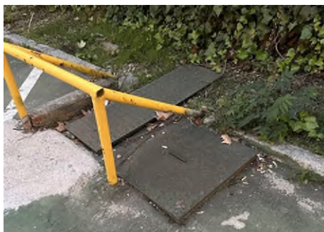
Figura 5 Ubicación de uno de los contadores de la ETSII bajo cubierta.
