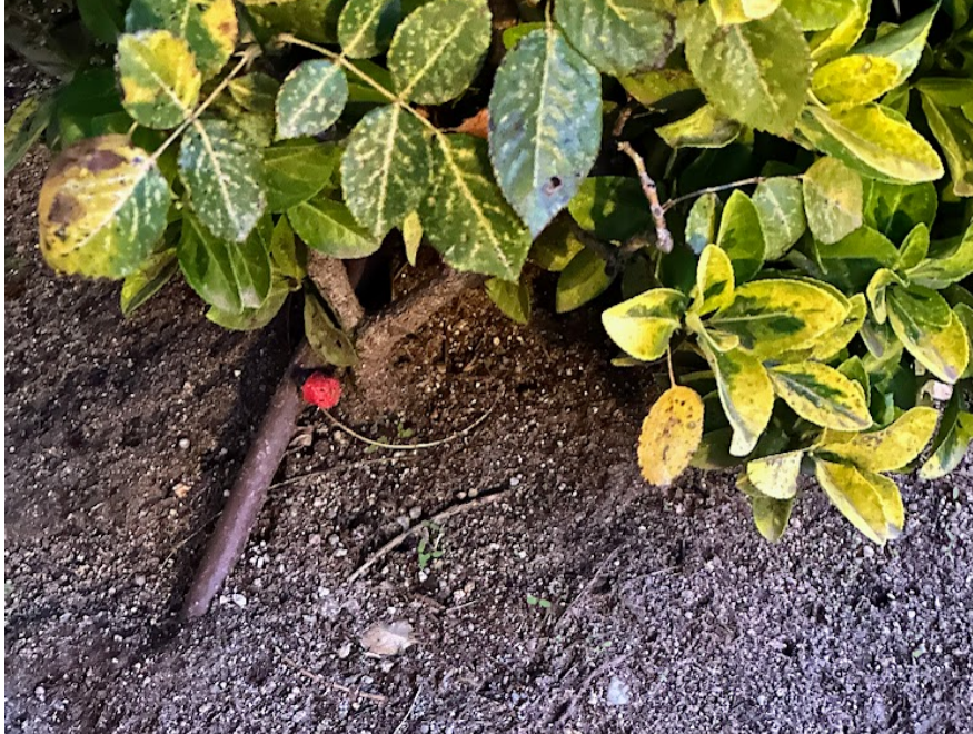
Figura 11 Ejemplo de un punto de goteo en la línea de riego automática instalada a lo largo de las zonas de árboles y arbustos del centro.
