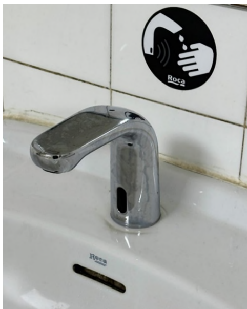
Figura 10 Grifo automático activado por medio de sensores en uno de los aseos del Edificio Principal, en la zona del aulario, instalados en 2021 en la ETSII (ETSII, 2020).
