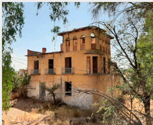
Casa-centro logístico para la construcción de la presa de Mengíbar, entre el río y la antigua carretera nacional. / Foto del autor.
