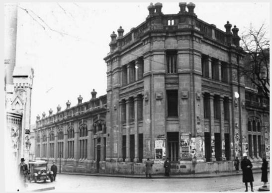
Fachada de los Talleres del I.C.A.I. / Fotografía: Santos Yubero. Archivo Regional de la Comunidad de Madrid. Sig. 043157.
