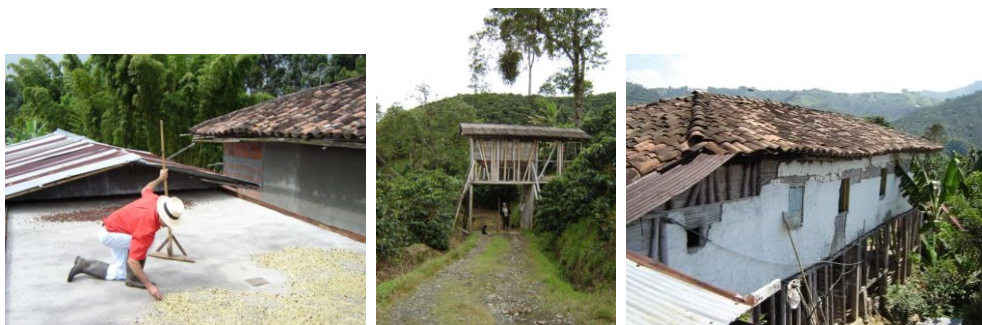
Figuras 71b. Helda, tolva y beneficiadero en semisótano. Fuente: propia, 2005.
