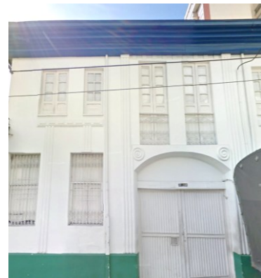
Fachada sobre la calle 33
