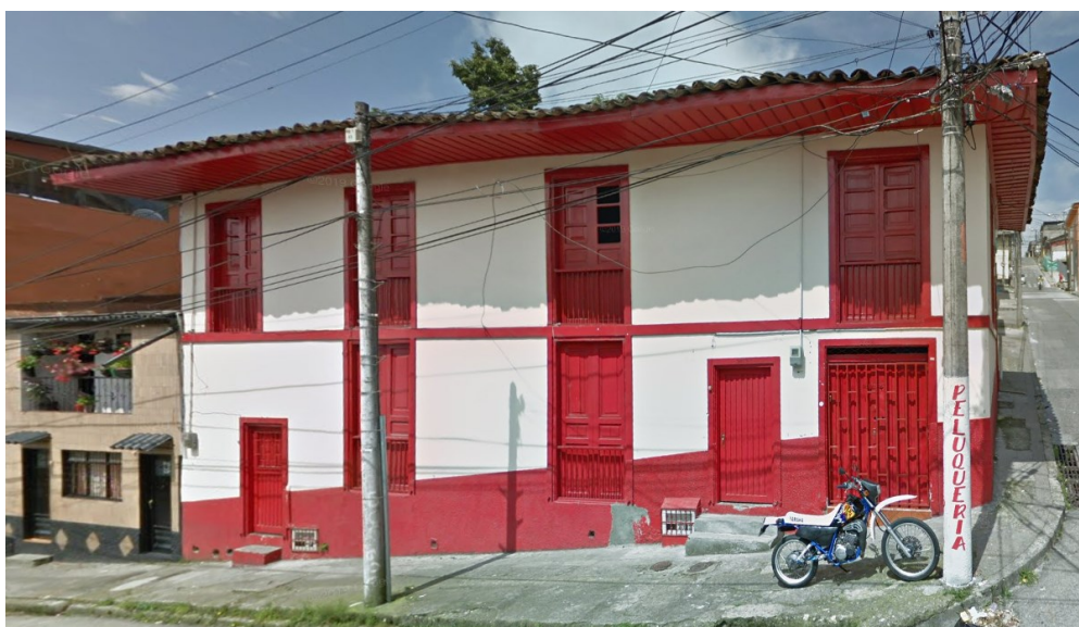
Figura 123. Vivienda localizada en la Calle 21 con Carrera 27, muestra un regular / buen estado de conservación. Fuente: Google Maps .
