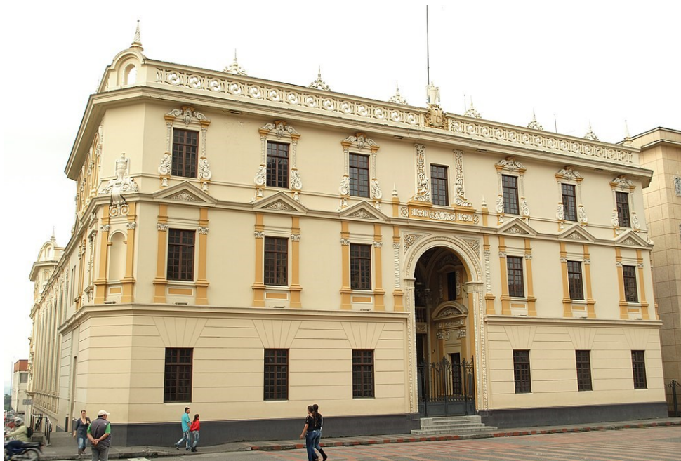
Figura 112. Edificio de la Gobernación de Caldas, carrera 21, calle 22, Manizales (Sánchez Gallego, 2012).
