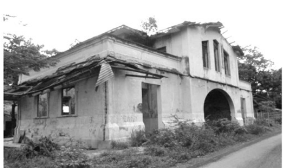
Restauración Estación del Ferrocarril Gualanday, Coello, Tolima
