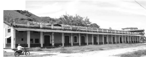
Mantenimiento Estación del Ferrocarril Cisneros, Antioquia
