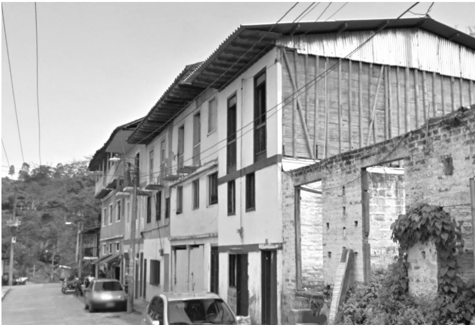
Figura 47. Estructura y cerramiento construidos en bahareque de guadua. Marsella, Risaralda. Fuente: Google Earth 2013 .
