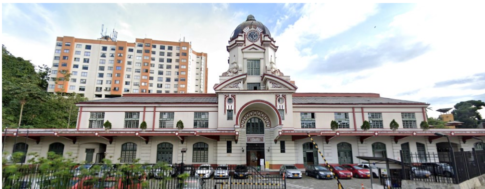
Figura 101. Estación del tren de Manizales. Fuente: Google maps 2021 .
