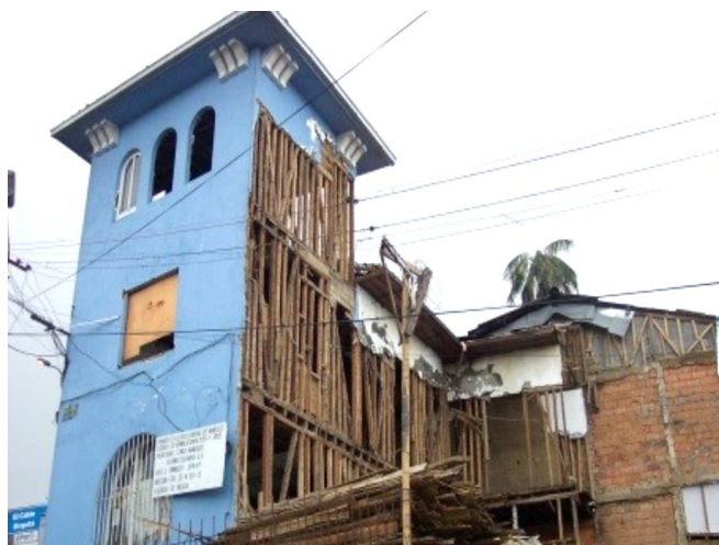
Figura 145. Antigua Clínica Manizales, 2005. Av. Santander (carrera 23) con calle 39, inaugurada en 1946. Esta parte del edificio fue demolida en 2009 (Muñoz Robledo et al., 2020, pág. 100).
