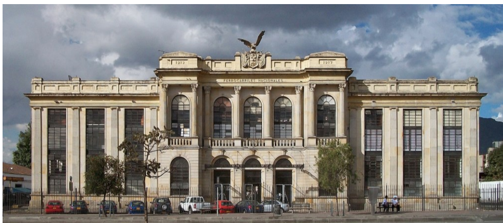
Figura 178. Estación del ferrocarril de La Sabana, Bogotá (Restrepo Acosta, 2010).
