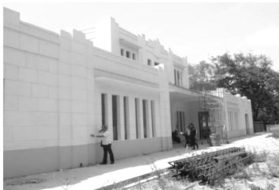
Restauración Estación del Ferrocarril Ambalema, Tolima
