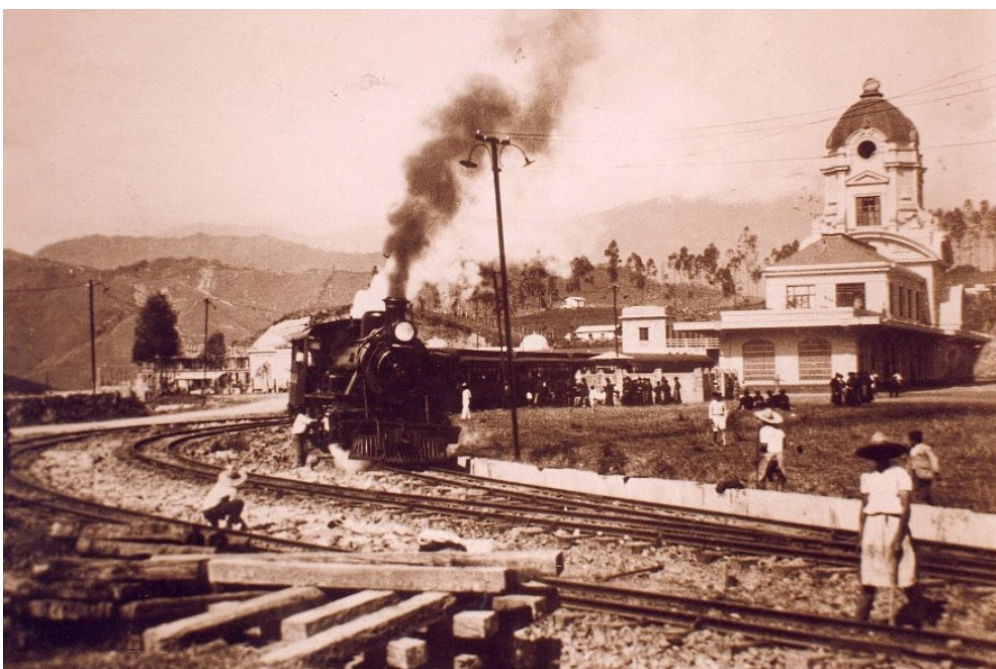
Figura 106. Estación del Ferrocarril de Caldas, Manizales. Fuente: Ferrocarril de Caldas 1930. Centro de Historia de Manizales (Poveda Ramos, 2003).
