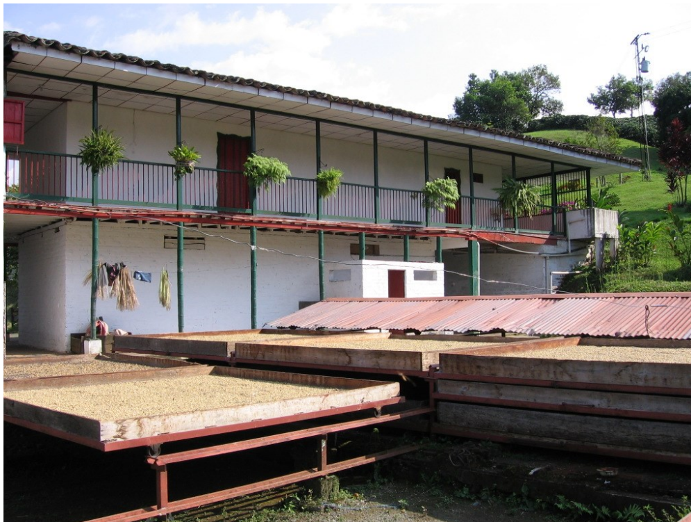
Figura 68. Heldas deslizables. Finca la Soledad, Palestina, Caldas. 2005. Fuente: Propia.
