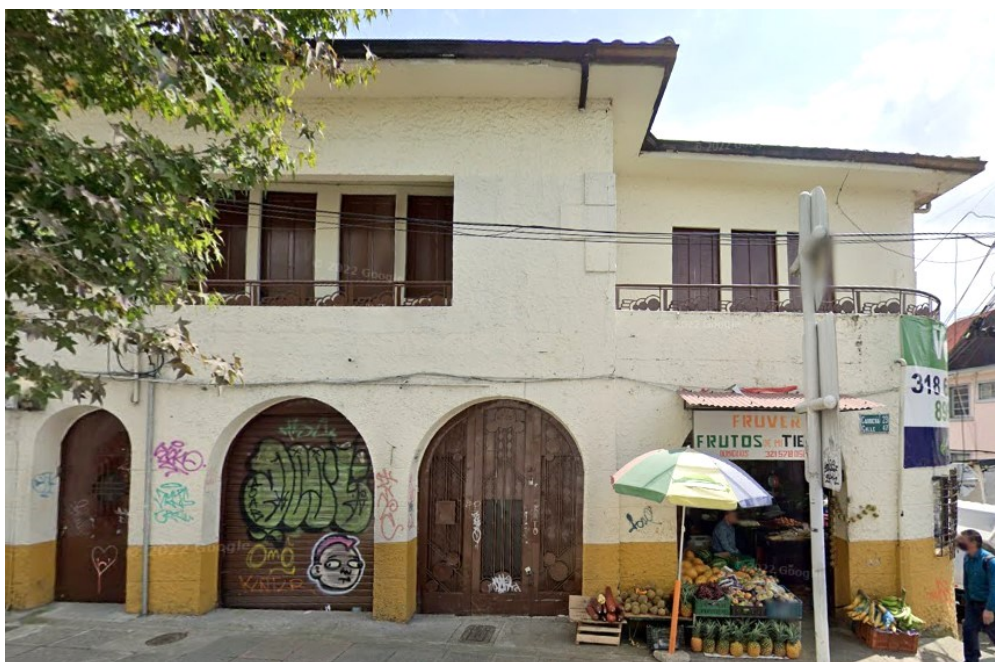
Figura 140. Vivienda que se localizaba en la carrera 23 (Av. Santander) con calle 47 esquina del barrio Lleras de Manizales, demolida en marzo de 2024. Fuente: Google maps, imagen capturada en 2021.
