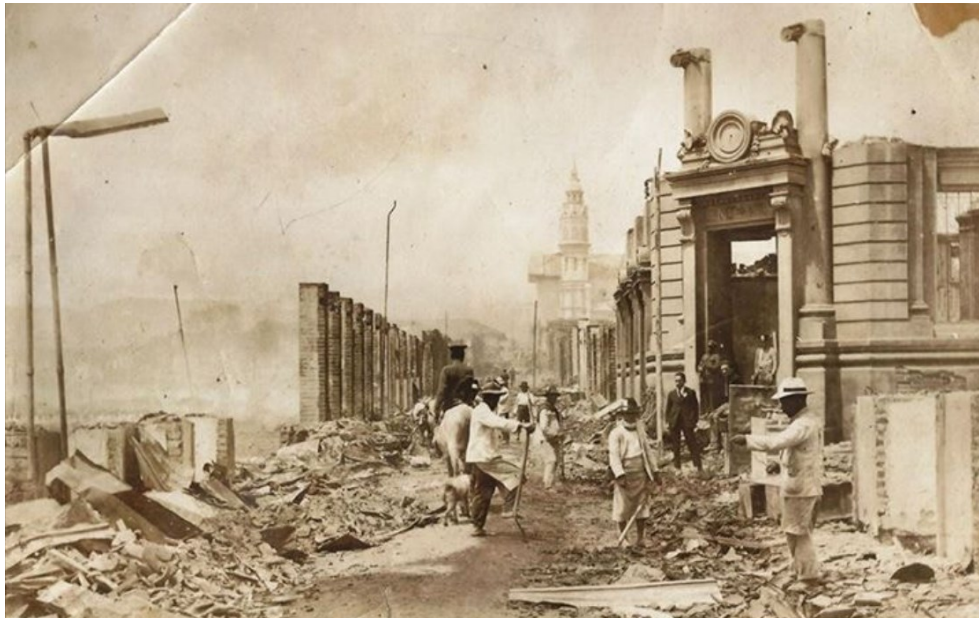
Figura 111. Ruinas del incendio de 1925 en Manizales. Fachada que quedó en pie del Banco del Ruiz, sobre la calle 21 carrera 22, demolido por completo para la reconstrucción del centro. Colección hemerográfica del Archivo Histórico de Manizales (AHM).
