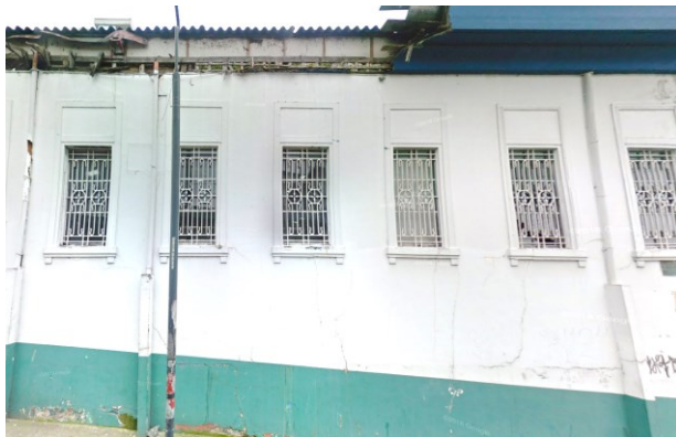
Fachada sobre la carrera 24
