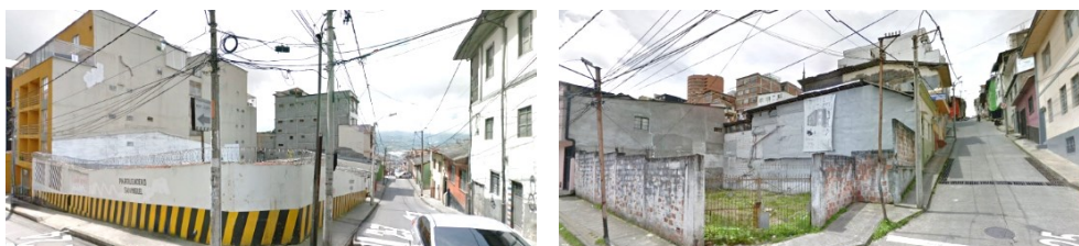
Lote - parqueadero y edificio nuevo. Cr. 23 x Cl. 27.
