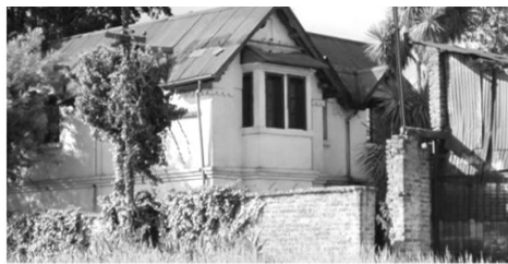
Mantenimiento Casa del Ingeniero. Estación del Ferrocarril de La Sabana, Bogotá D.C.
