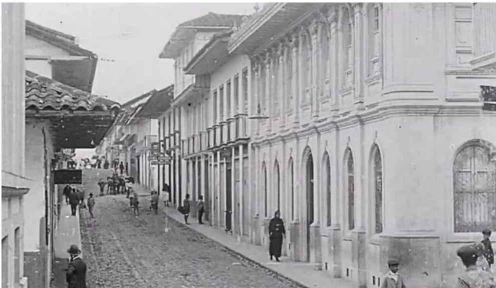
Figura 110. Centro de Manizales. C.a. 1925, antes del incendio de ese año. En esta imagen pueden verse edificaciones de arquitectura tradicional de la colonización antioqueña y otros que integran lenguajes formales de la arquitectura republicana. Colección hemerográfica del Archivo Histórico de Manizales (AHM).
