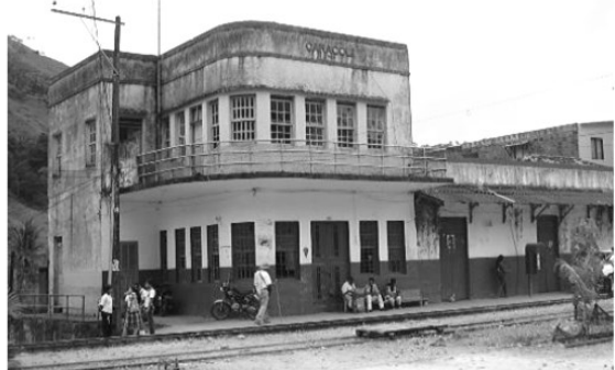
Restauración Estación del Ferrocarril Caracolí, Antioquia
