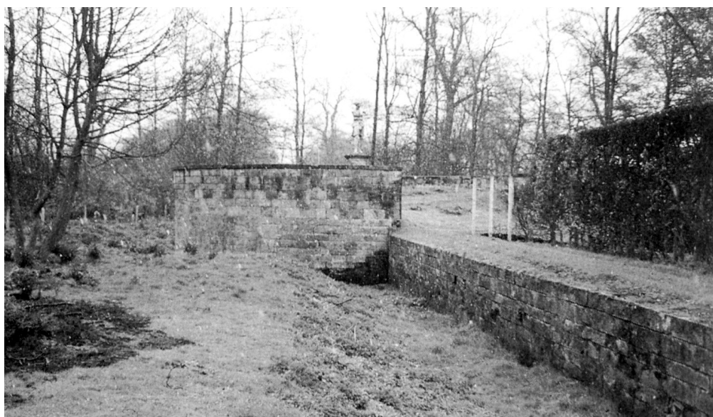
Figura 15. Seaton Delaval . Fotografía del encuentro del ha-ha con uno de los bastiones circulares del perímetro (Williams y Ridgway 2000:61). Seaton Delaval Hall , viewed from north-west
