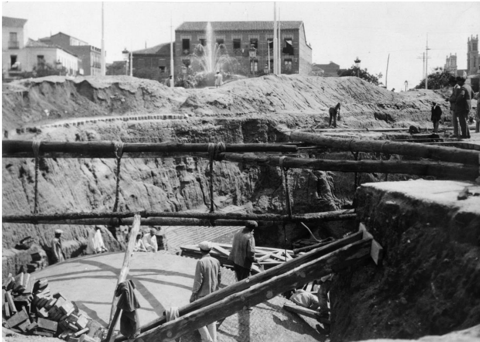
Construcción del túnel de Cocheras en la Glorieta de Ruiz Jiménez. 1917. Archivo Histórico de Metro.
