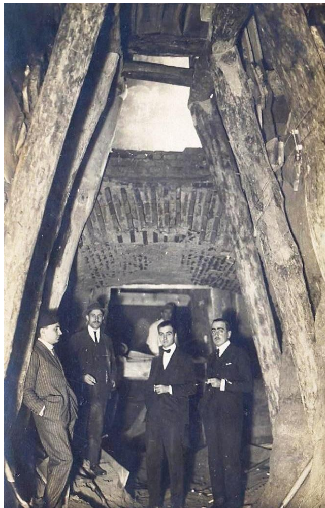
Visita a las obras del Metropolitano en la Puerta del Sol el 18 de Junio 1918. Colección particular. Antonio Palacios de perfil y apoyado a la izquierda y Miguel Otamendi en el extremo opuesto.
