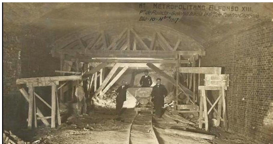
Vista del túnel de Cocheras ya edificado. 10 de Noviembre de 1917. Colección particular.
