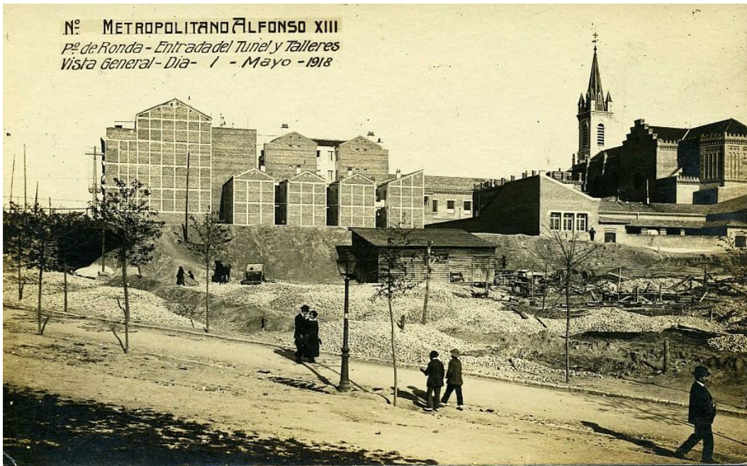
Obras de construcción de las Cocheras (01/05/1918), con el Camino de Aceiteros en primer término. Contra el terraplén se aprecia el Taller de Herrería licitado por Palacios como casilla de obras. Museo de Historia de Madrid. Inv. 2007/17/2
