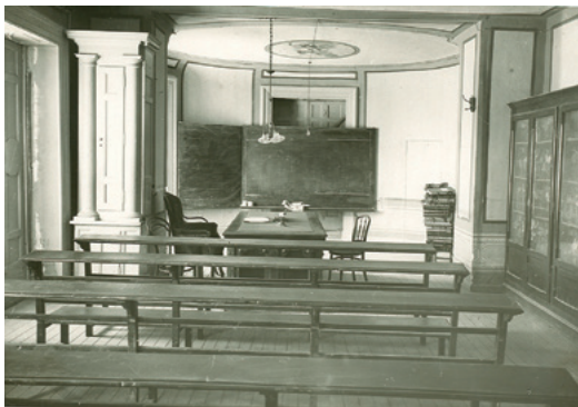
Figura 25. Salón oval de la Fábrica de Porcelana transformado en aula. S.f. Fuente: Fondo fotográfico de la ETSI Agronómica, Alimentaria y de Biosistemas. UPM.
