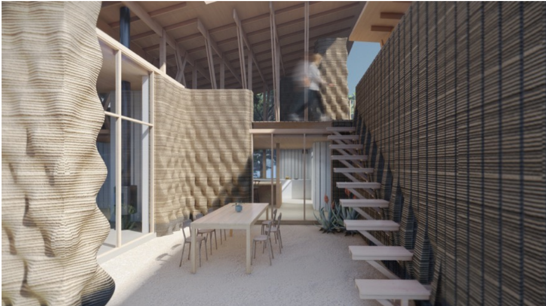
Figura 2.1.2 / 22: Prototipo Tova de casa sostenible, asequible y de rápida ejecución mediante impresión 3D (Sistema Crane Wasp): kilómetro cero / madera y tierras arcillosas. Fuente: DPAARQUITECTURA . Valldaura Labs_ . 29 de septiembre 2022
