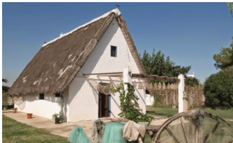
Figura 2.2.1/ 10: Vista de barraca valenciana , fachada principal orientación sur con emparrado.
