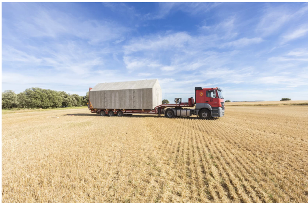
Figura 2.1.4.2 / 1: Transporte por carretera de casa industrializada hasta su emplazamiento. Fuente: Casa Abatón
