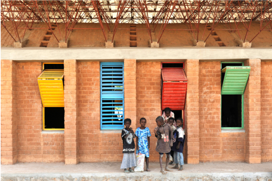
Figura 2.3.1 / 9: Escuela Primaria en Gando (Burkina Faso). Fuente: Kéré Architecture (cortesía de Pritzker Architecture Prize)
