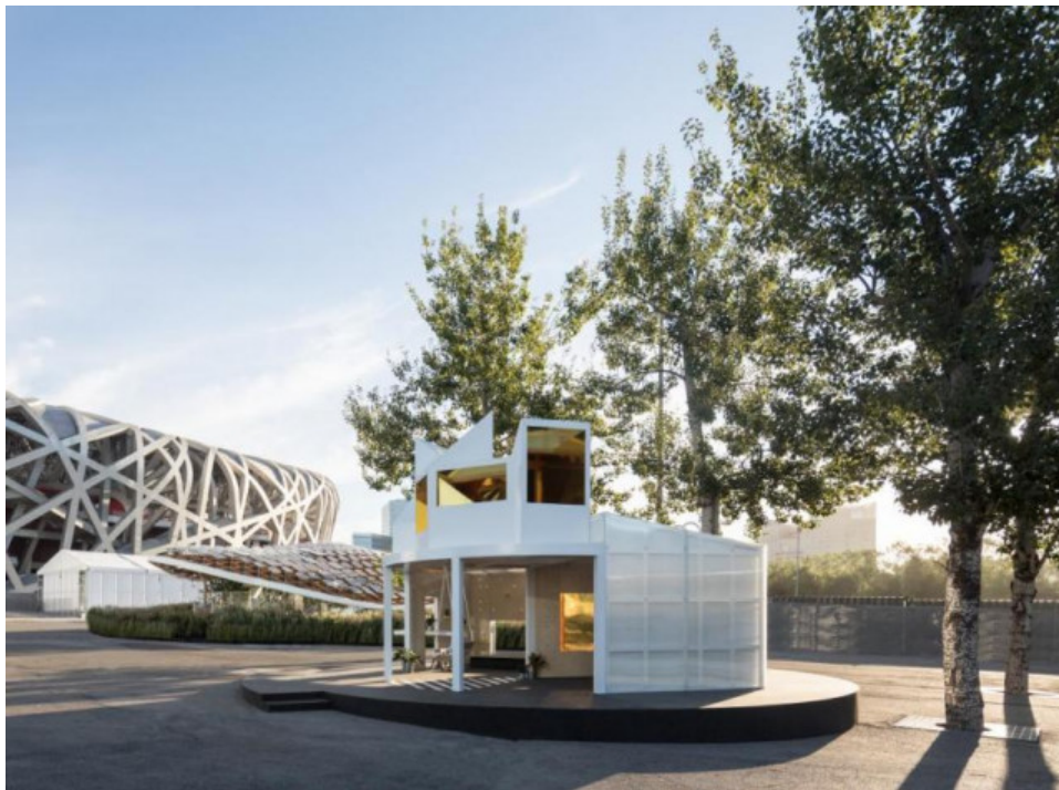
Figura 2.1.4.2 / 6: Casa mini-living de 15 metros cuadrados construidos
