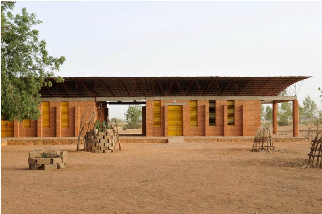
Figura 2.3.1 / 8: Escuela Primaria en Gando (Burkina Faso). Fuente: Kéré Architecture (cortesía de Pritzker Architecture Prize)
