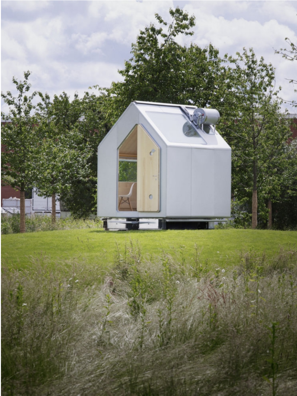
Figura 2.3.2 / 17: Casa industrializada autosuficiente: Vista cercana desde el noreste Prototipo-Diógenes – Renzo Piano Fuente: Casa Vitra (2013)
