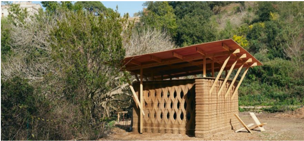
Figura 2.1.2 / 20: Prototipo Tova básico, impresión 3D (Sistema Crane Wasp). Fuente: DPAARQUITECTURA . Valldaura Labs_ . 29 de septiembre 2022
