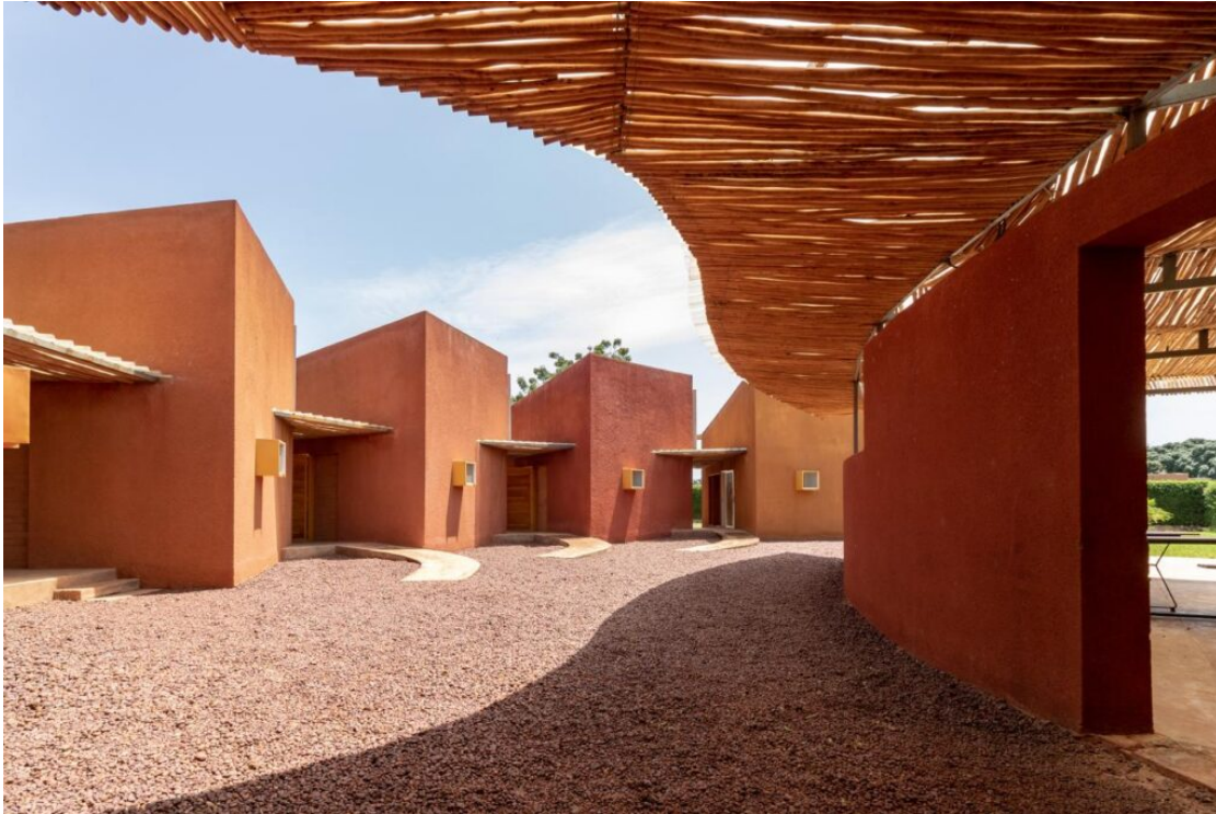
Figura 2.3.1 / 11: Casas para médicos en Léo (Burkina Faso) Fuente: Kéré Architecture (cortesía de Pritzker Architecture Prize)
