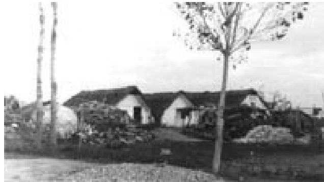
Figura 2.2.1/ 4: Vista exterior de barracas situada en el Delta del Ebro. Fuente: Museo de Etnología de Montsia (Tarragona).
