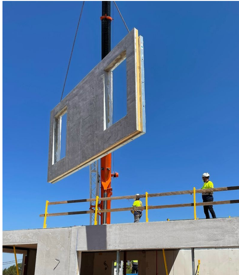
Figura 2.1.4.1/1: Montaje panel de hormigón de casa prefabricada.
