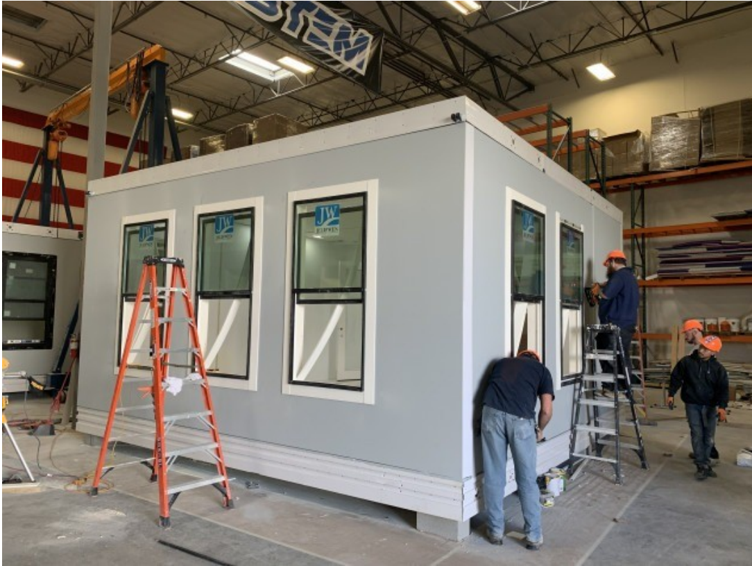
Figura 2.3.2 / 53: Prototipo de casa industrializada construida en factoría. Promotor Elon Musk. Fuente: Boxabl - Kevorkdjansezian
