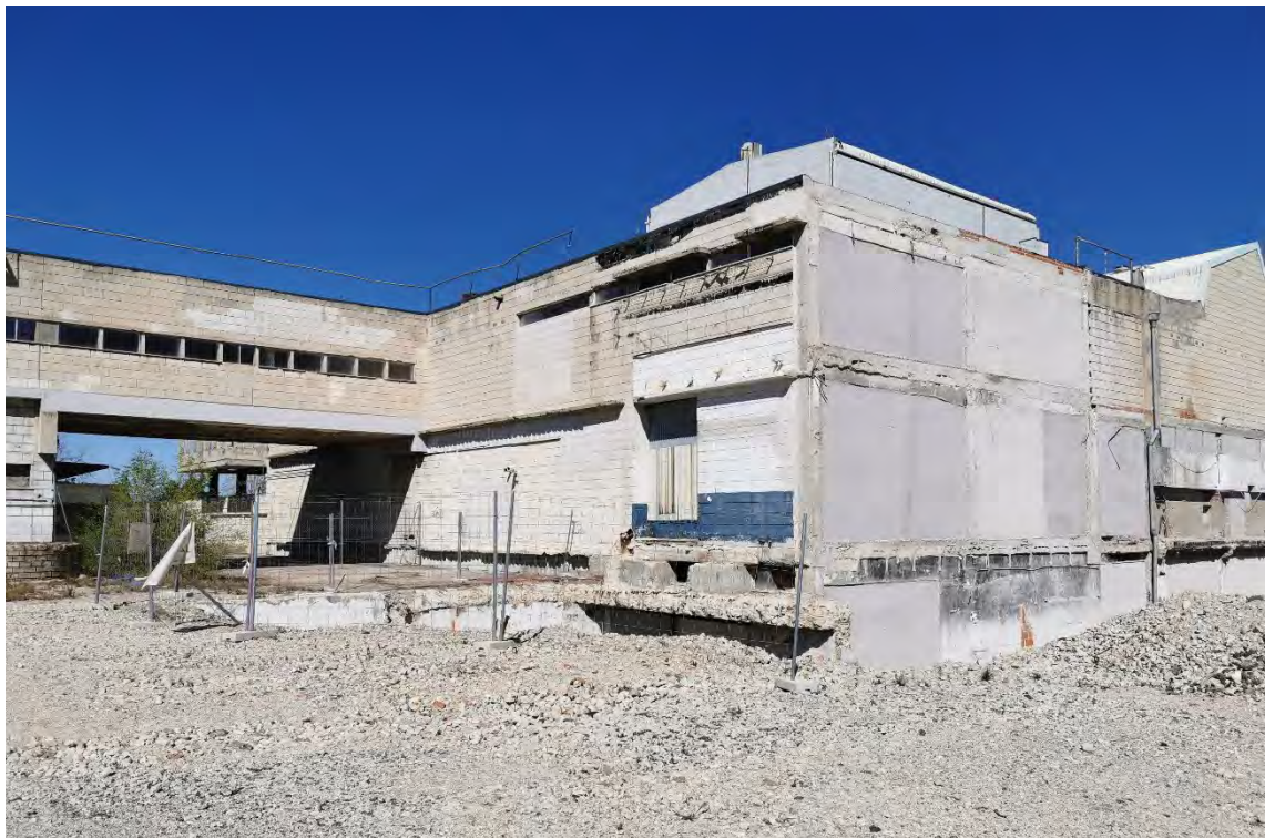
Figura A41. Ángulo sureste con vista del puente de laboratorios y conexión con nave de recepción de leche. Se aprecian las marcas de las demoliciones más importantes realizadas recientemente y los tabiques de cierre circunstanciales posteriores. Autor. 2023/04/04.
