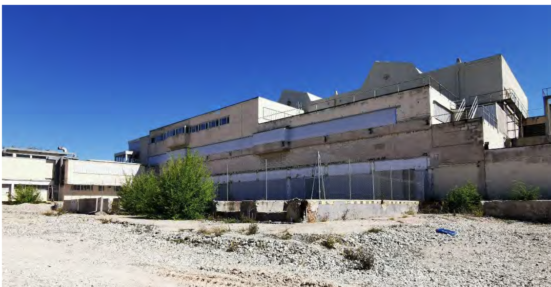
Figura 13. Estado actual de la fachada oeste con demolición de cubierta sobre muelles de carga ampliados y paneles traslúcidos sobre de franja de carpinterías originales en primera planta. Autor. 2023/04/04.
