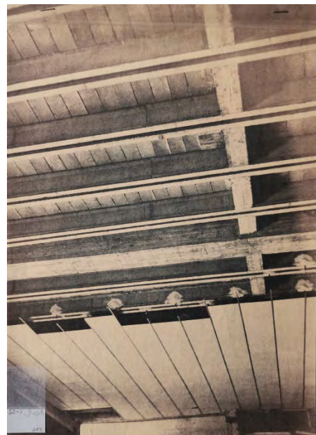
Figuras A47 y A48. Colocación de planchas Polydros de revestimiento de la estructura. Fundación A. de la Sota.
