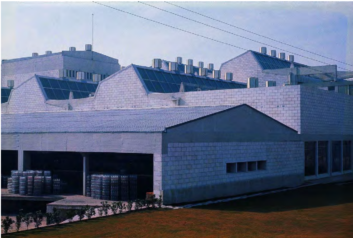
Figura 22. La solución de bloque prefabricado de revestimiento. El despiece es nítido por el rebaje en los bordes creando líneas de sombra. Fundación A de la Sota.
