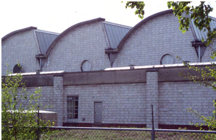
Figura 22. Fábrica Jamin, Oosterhout, Países Bajos, 1956. Pionera del revestimiento de bloques Ytong en fachadas industriales y con semejanzas aparentes con la solución adoptada en CLESA. Autor 2004.
