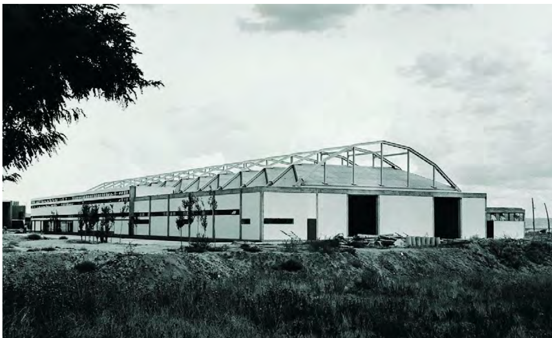
Figura 23. Taller de motores TABSA. 1957. El tema de la iluminación cenital fue también aquí protagonista. Fundación A. de la Sota.
