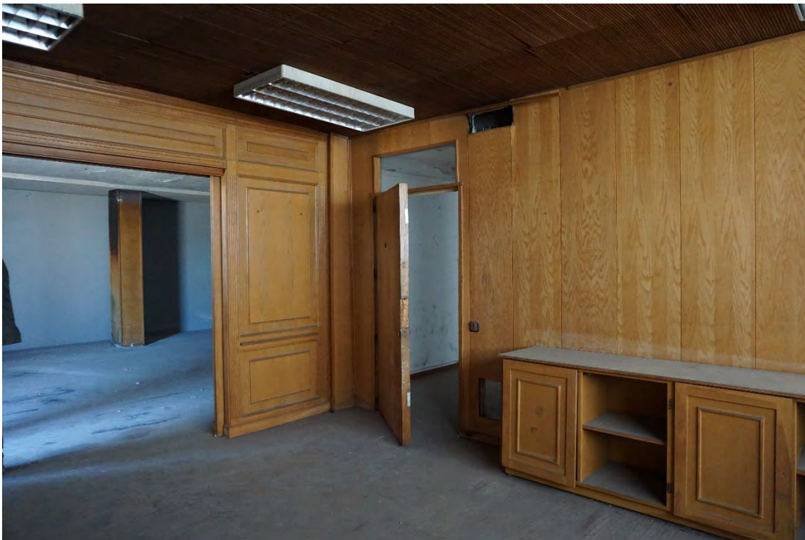
Figura A39, Despacho de dirección. La puerta es de 7 cm de espesor con fijación por imanes. M.T. Escaño. 2023/04/04.
