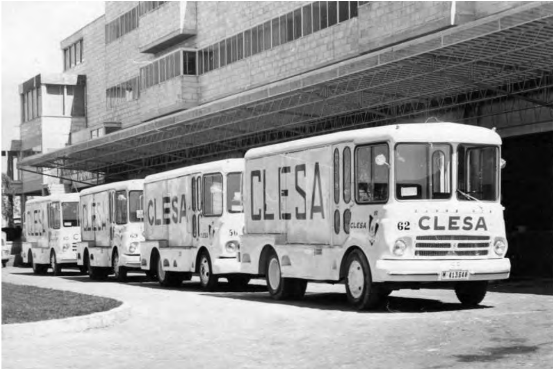
Figura A60. Vehículos de reparto bajo la marquesina metálica en muelle de carga. Posteriormente demolida por la ampliación del muelle de carga. Fundación A. de la Sota.
