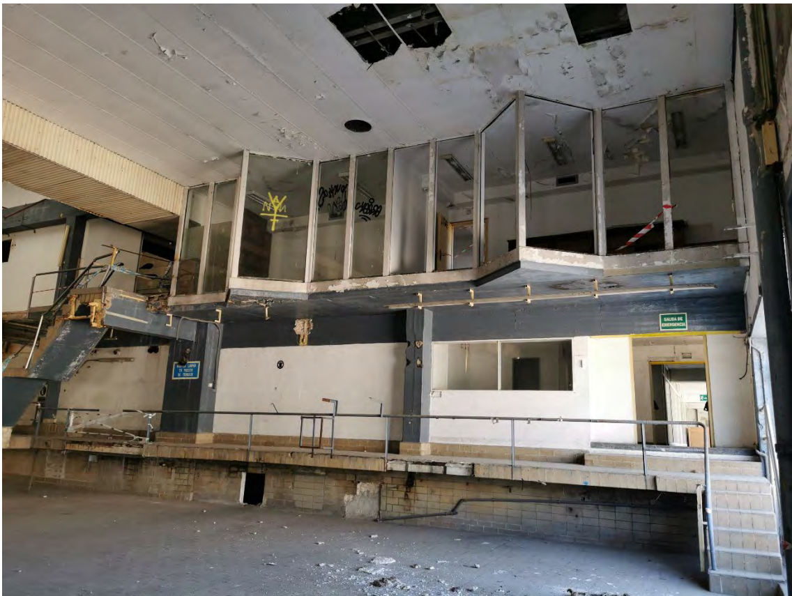
Figura A26. Estado actual de miradores. Autor 2023/04/04
