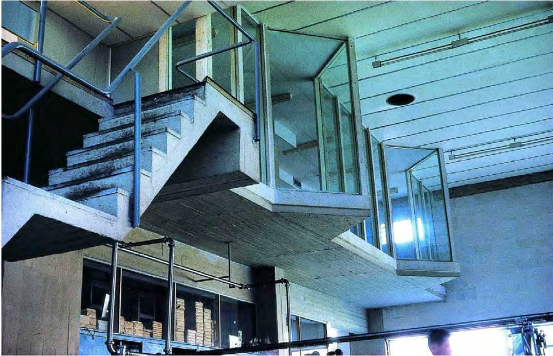
Figura A25. Miradores de despachos en nave producción. Archivo A de la Sota.
