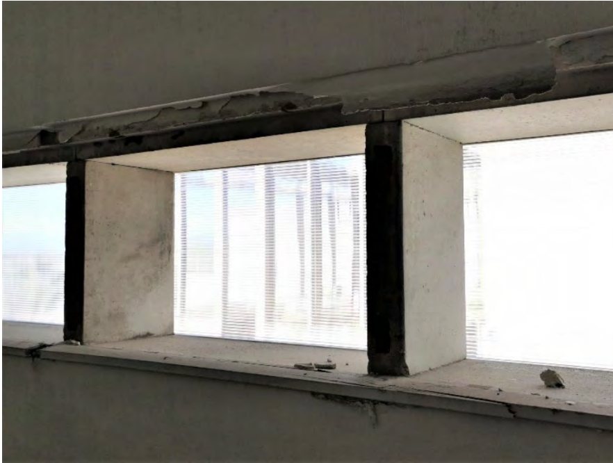
Figura A52. Marcos de hormigón con montantes especiales tipo pantalla con sección alargada para carpintería exterior. Autor. 2023/04/04.
