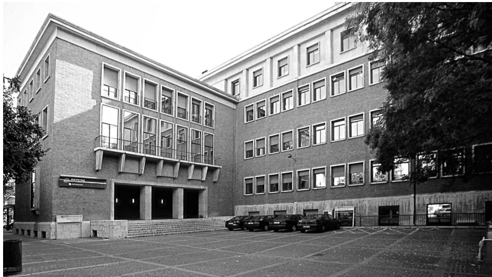
Figura 8. Fernando Moreno Barberá. Centro de Investigación hidrocarburos empresa Calvo Sotelo (Encaso), Madrid. 1953. Edificio de administración.
