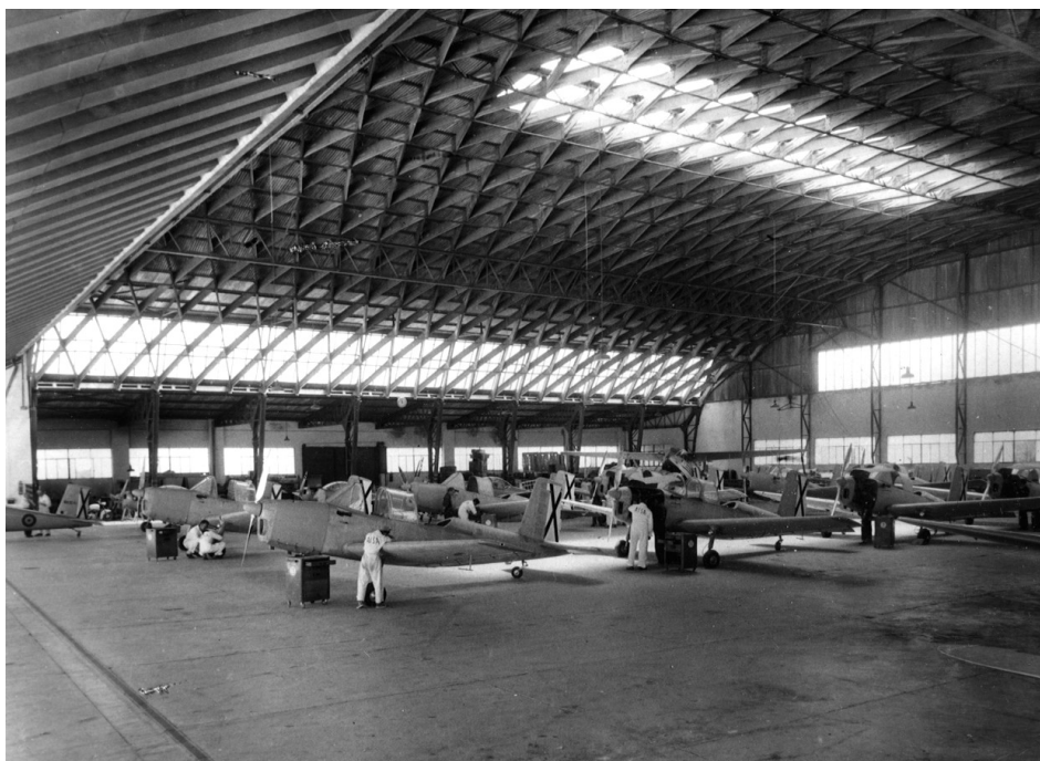
Figura 5. Interior del hangar con aviones de entrenamiento I-115. La jácena horizontal bajo la cubierta no es estructural y sirve como carril de gancho elevador (SEPI 03575* Álbum 10/65/3 1961).
