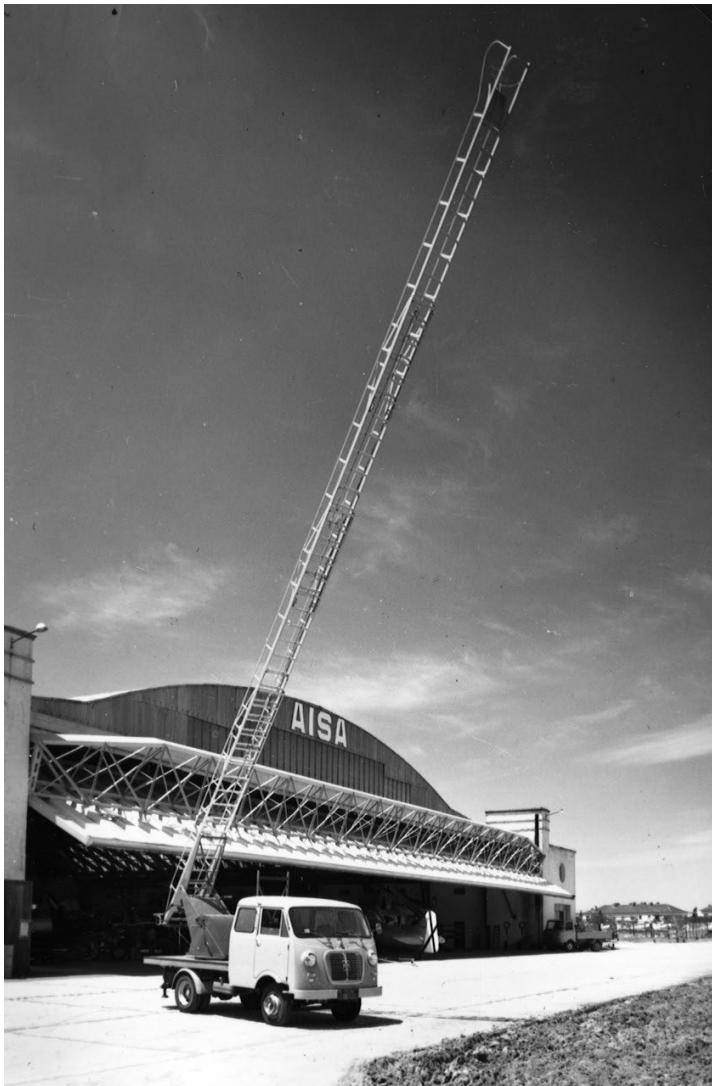
Figura 8. El hangar con la puerta semiabierto y camión AVIA con escalera extensible de 16 m (SEPI 03597* Álbum 10/72/1 1965).
