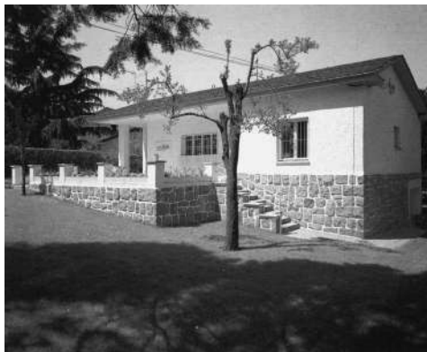
Vista de vivienda original. Casas Baratas: La vivienda social en Madrid..., 1992
