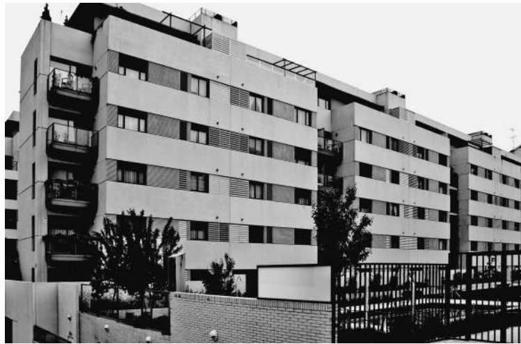
Vista exterior, bloque de la Ilustración
