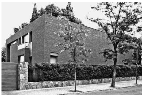
Vista exterior de vivienda unifamiliar en C/ Nuria
