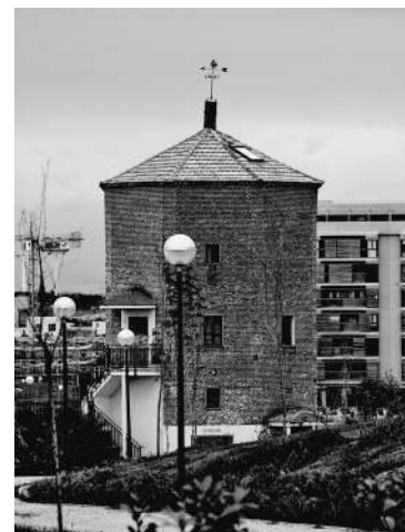
Palomar preexistente en la zona ajardinada de la calle Capiscol
