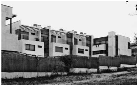
Vista exterior viviendas en hilera en C/ Marbella
