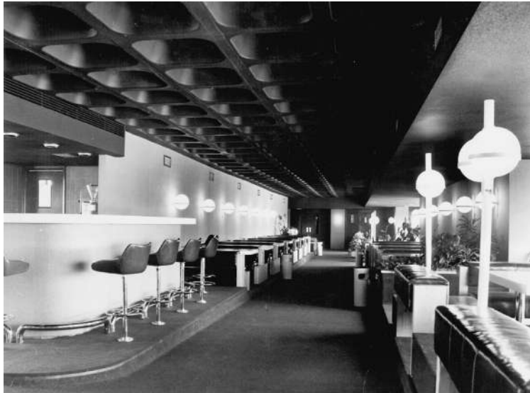
Vista interior. SH.COAM
