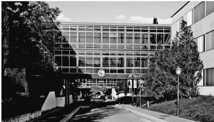
Vista exterior galerías edificios centrales
