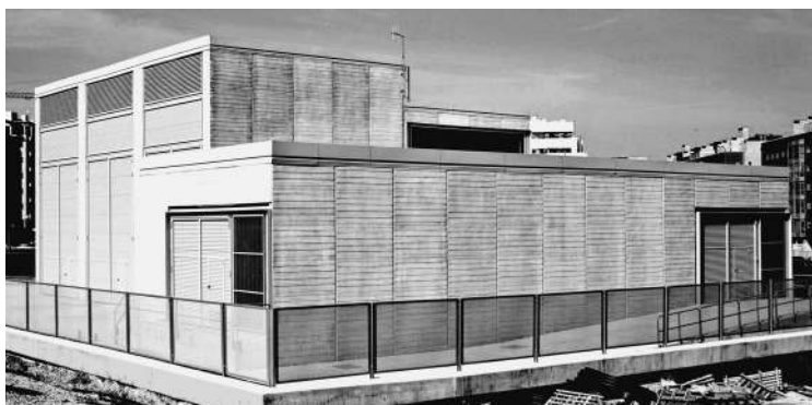
Centro de Transformación de Iberdrola
