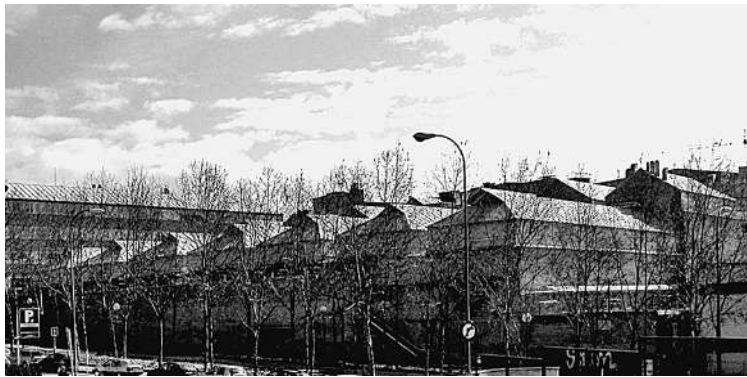
Foto fachada oeste
