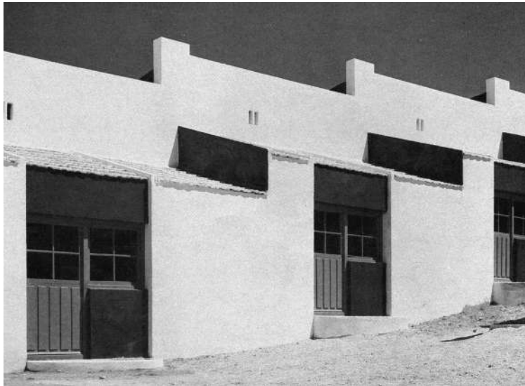
Vista viviendas en hilera tipo B durante la construcción. Alejandro de la Sota: catálogo exposición COAM, 1988
