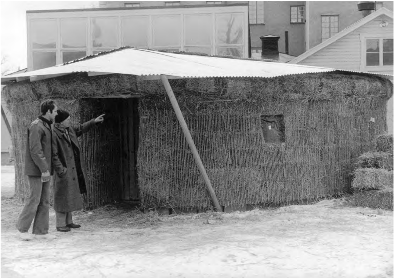
Fig.27. Casa de Paja para la exposición A.R.A.R.A.T. en Estocolmo, que se celebraría en marzo de 1972. Anshelm y Peter Torudd con la casa de paja terminada. Anshelm, ya enfermo y débil, colaboró en la construcción con sus propias manos. Todos los participantes pudieron ver como el arquitecto, que gozaba ya de cierto prestigio, construía con sus propias manos, en pleno invierno, aquella cabaña primitiva. Como un pionero recién llegado a un nuevo lugar. "Sus manos", recordando a Morris, "habían sido guiadas no solo por sus propios pensamientos, sino por los hombres de siglos pasados".
