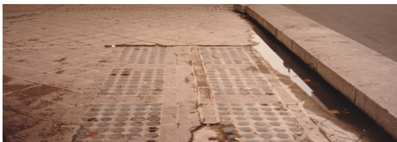
Figura 48. Calzada en las inmediaciones de la glorieta de Alonso Martínez, bajo la que se sitúa el tramo del viaje de la Castellana que fue susceptible de acondicionamiento.
