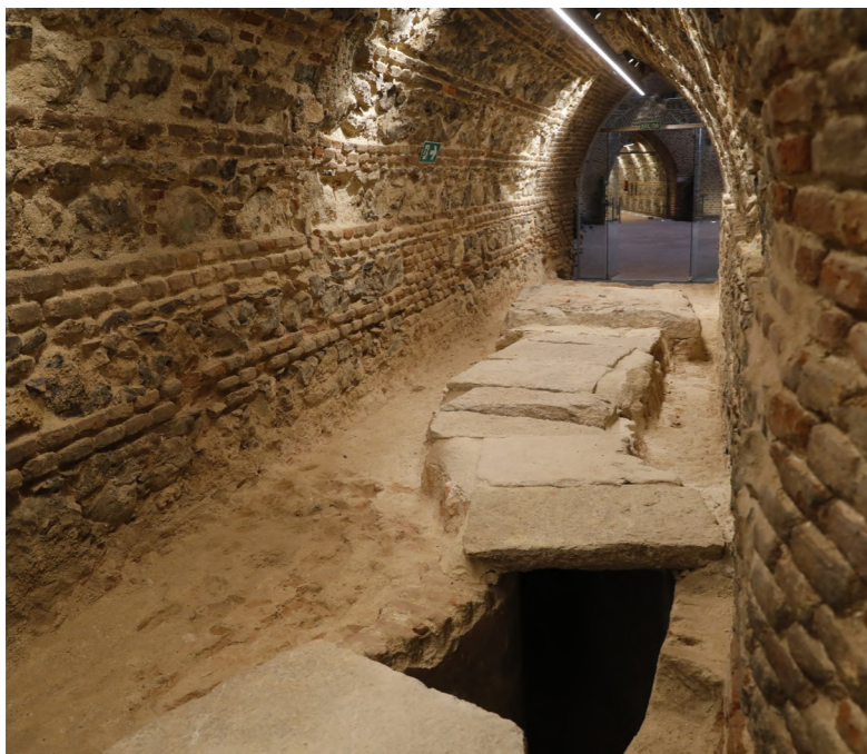
Figura 56. Recuperación de galería del viaje de agua encontrado durante las obras de restauración de la Montaña Artificial del Retiro.
