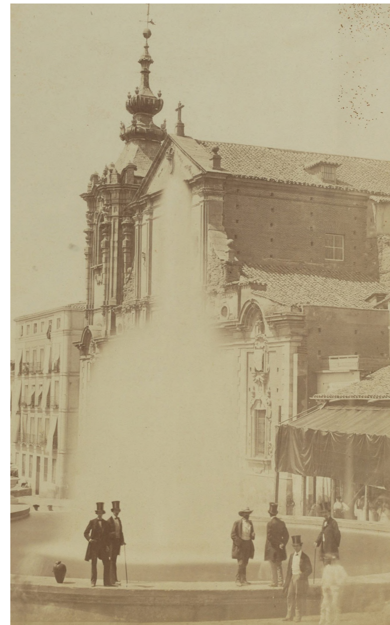
Figura 37. Inauguración del Canal. Fuente provisional de la calle San Bernardo exponía la nueva obra hidráulica con un chorro a presión que se elevaba 90 pies de altura. Fotografiado por Charles Clifford, 1858.
