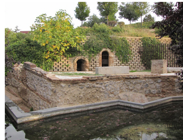
Figuras 54 y 55. Fotografías de la recuperación del viaje de agua de Amanuel.
